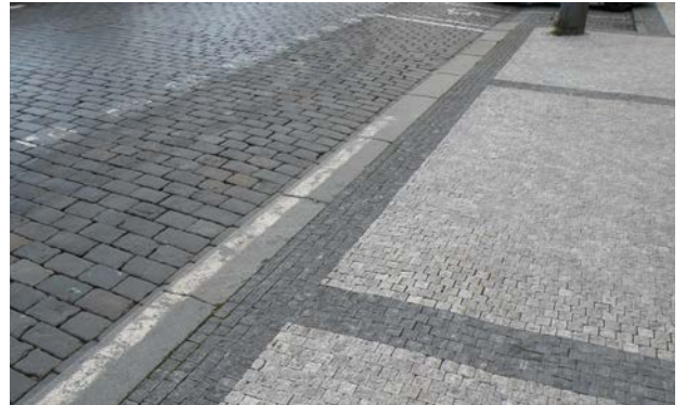
Vozovková žulová dlažba a pražská mozaika na chodníku v uličním prostoru podél fasád budov
