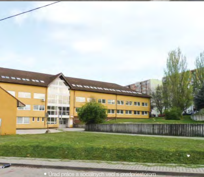
• Občianske vybavenie pozdĺž ul. Nitrianska
