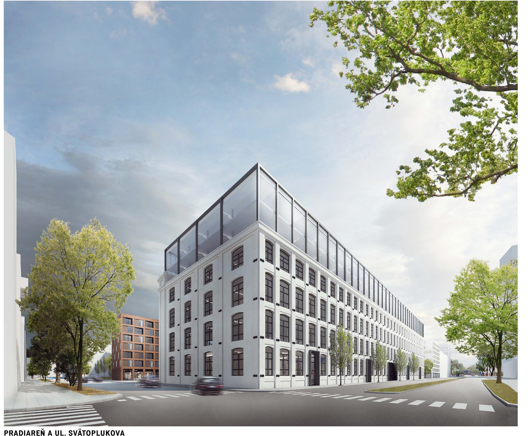
PRADIAREŇ A UL. SVÄTOPLUKOVA
