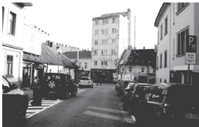
Prístup z Vysokaj ulice
