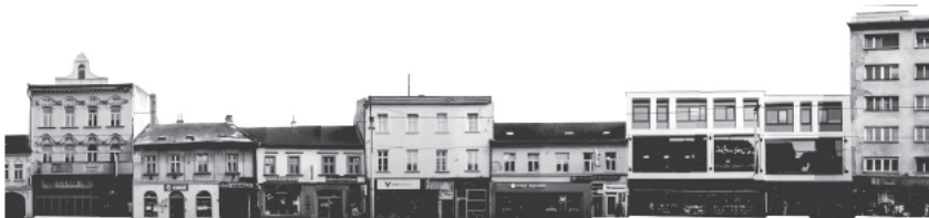
Nevyrovnaná výšková skladba budov
