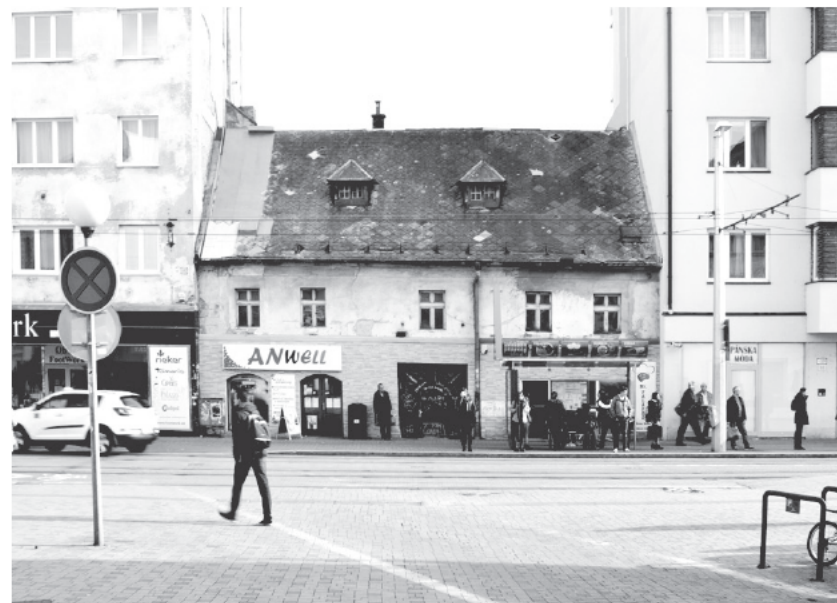
Nevyrovnaná výšková skladba budov
