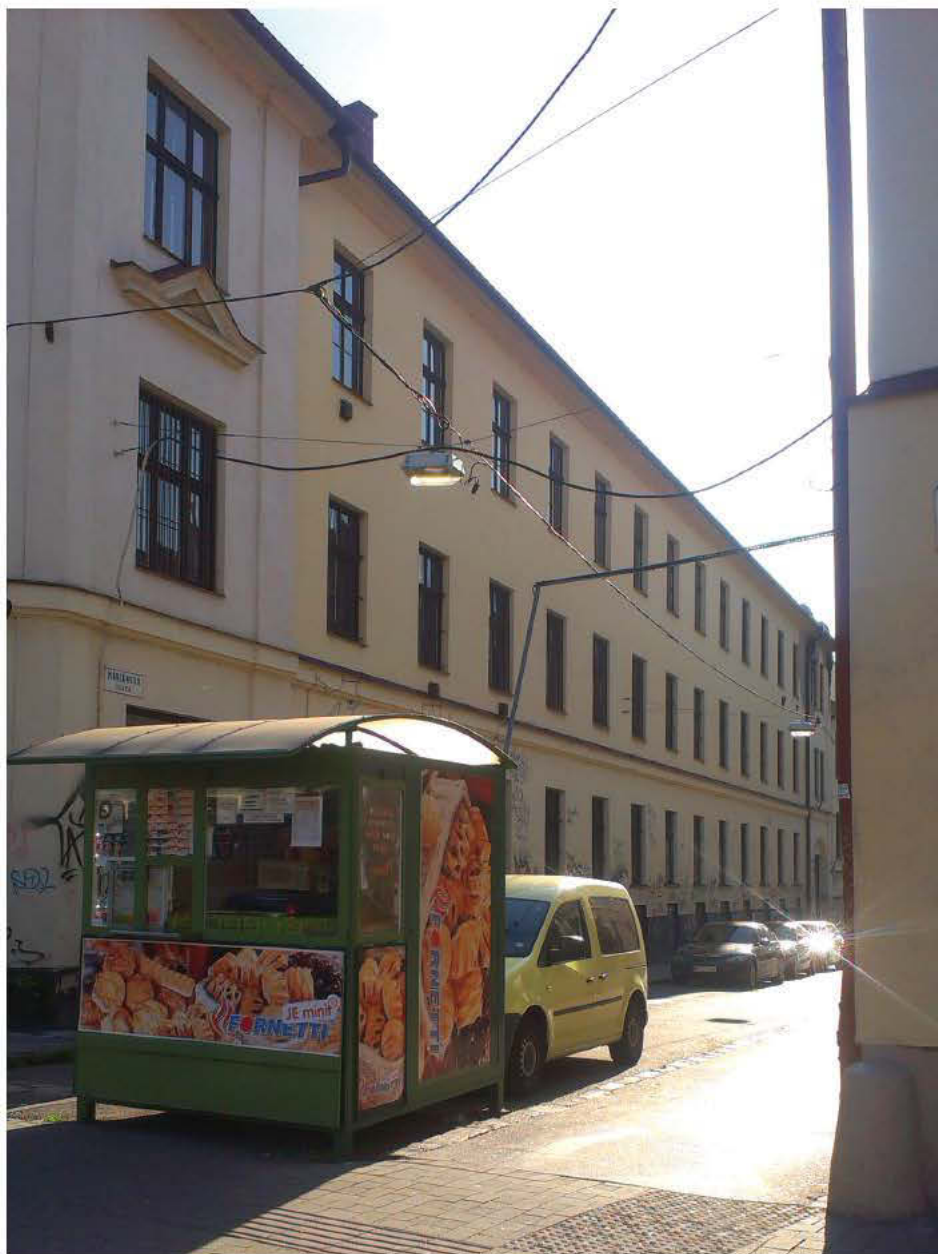
Bariéra na vstupe z Obchodnej ulice smerom na Mariánsku ulicu. Foto: Stanislava Kočišová_2015
