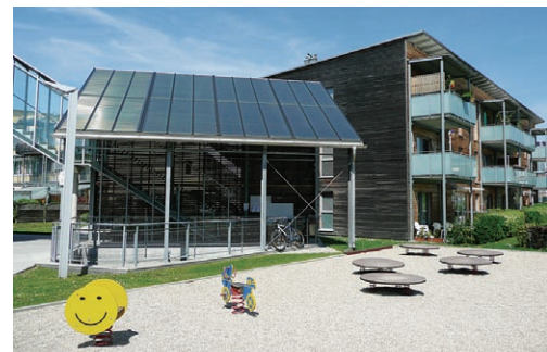
Prstreok v SolarCity Linz zaistuje tepl vodu pre cel bytov dom. (foto H. Pfko)
