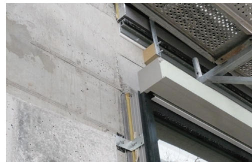
Okno vysunuté do (budúcej) tepelnej izolácie bez tepelných mostov je typickým prvkom úsporných budov. (foto H. Pifko)
