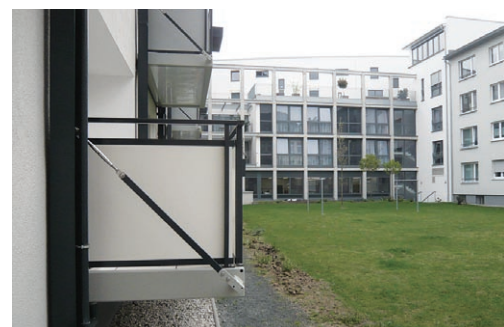
Balkóny môžeme k izolovanej stene pristavať (SolarCity Linz), zavesiť (Frankfurt) či oddeliť od železobetónového stropu „isokorbami“ – spoločným menovateľom odporúčaných riešení je minimalizácia tepelných mostov. (foto H. Pifko)
