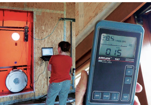
Blower-Door Test (BDT) umožňuje zistiť nielen intenzitu výmeny vzduchu, ale aj miesto netesnosti. (foto H. Pifko)
