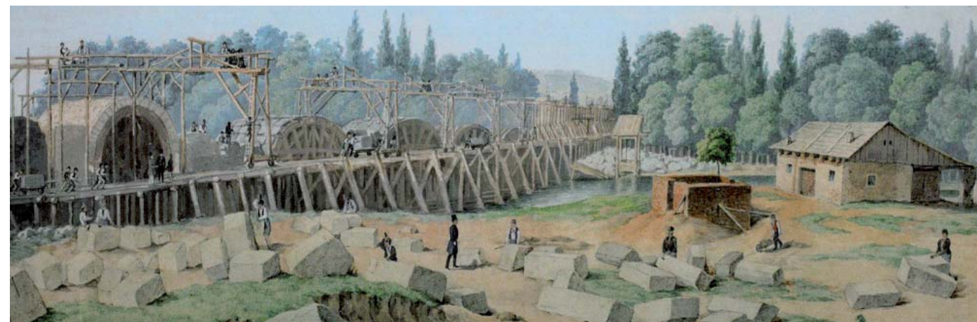
Stavba železničního viaduktu pražsko-dráždanské dráhy // Construction of the viaduct for the trainline connect Prague – Dresden, B. Anděl, 1848. Reprint: Karlín. Nejstarší předměstí Prahy, Zdeněk Míka, Muzeum hlavního města Prahy, 2011.
