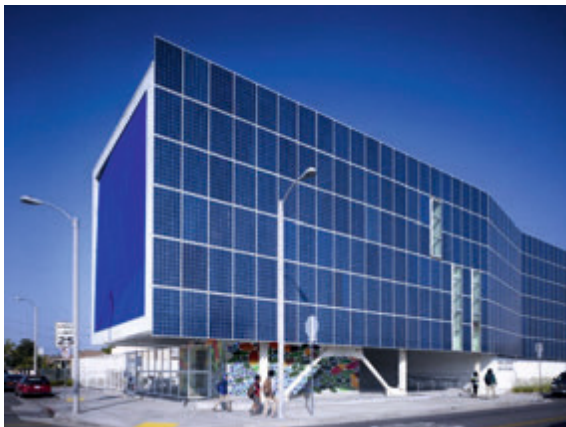
■ obr. 157_Green Dot Animo Leadership High School Južnú fasádu školy v Inglewood, USA, od architektov Brooks&Scarpa pokrýva 650 fotovoltických panelov, zabezpečujúcich 75 % energie potrebnej na jej prevádzku.
