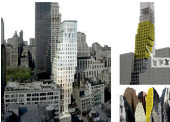
■ obr. 52_Architektonická štúdiá od ateliéru OMA (OMA, Office for Metropolitan Architecture) Rema Koolhaasa na 23 East 22nd Street ako reminiscencia na Zónový zákon z roku 1916 a jeho dôsledky – „Set-back Buildings“. Vyrastá z 33 stôp (10,06 m) širokého pozemku a postupne sa vysojuje do konzoly, ktorá v najvzdialenejšom bode presahuje 30 stôp (9,14 m) nad okolitú zástavbu. Objekt s 24 podlažiami dosahuje výšku 355 stôp (108,20 m) a jasne dominuje Flatiron Districtu s prevažujúcou 10 až 12 poschodovou obytnou zástavbou. „Je to typická budova New Yorku, len postavená na hlavu“, tvrdí Jason Long, architekt newyorskej pobočky ateliéru OMA. Zámerom uskakovania objektu je zabezpečenie prísunu slnečného žiarenia na terasu susedného objektu a nebráni chodcom vo výhľade na blízku budovu One Madison Park.
