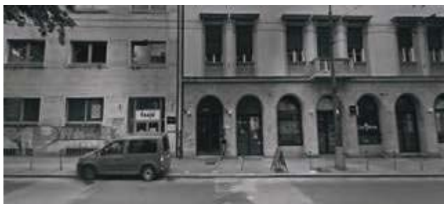
7 vstup do kultúrnych inštitúcií blokovaný autami
