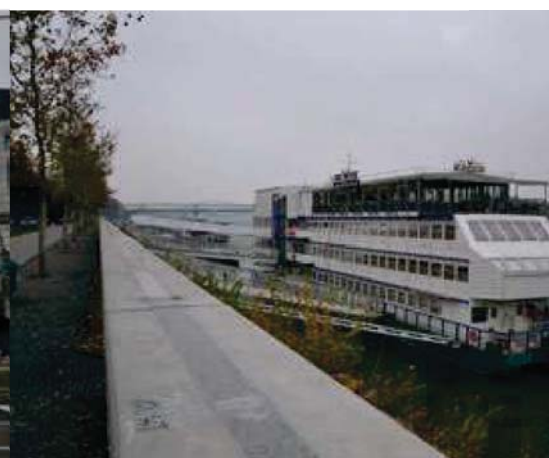
vysoký protipovodňový múr
