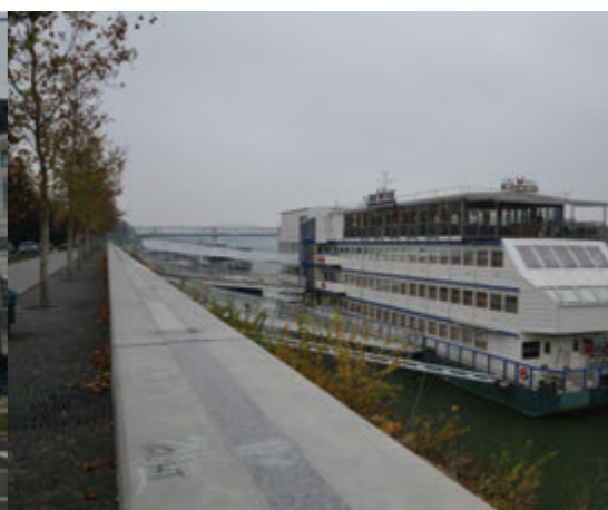
vysoký protipovodňový múr
