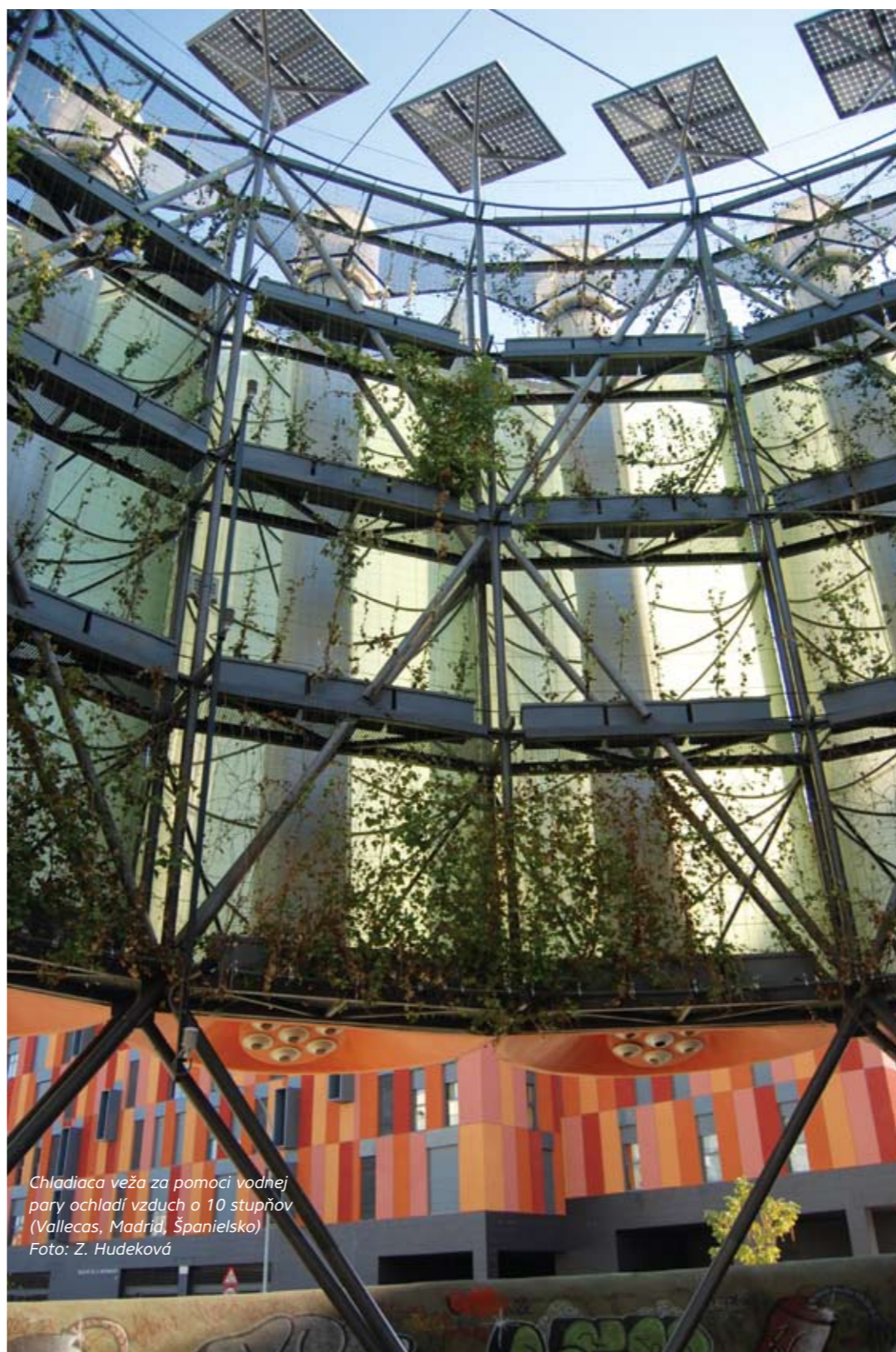
V novej madridskej štvrti Vallecas vybudovali pre obyvateľov „chladiace“ veže, ktoré poskytujú osvieženie v dobe letných horúčav Foto: Z. Hudeková
