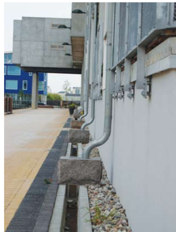
Zrážková voda sa zachytáva priamo pod zvodni a ďalej je vedená do vsaku alebo retencie Foto: Z. Hudeková
