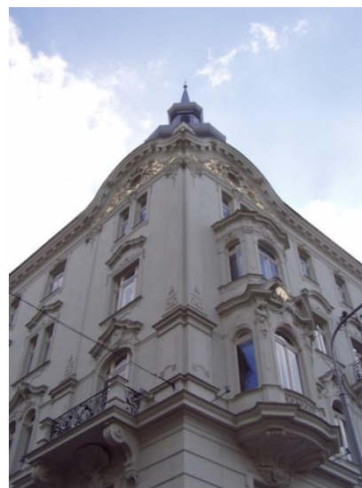
Rekonštrukcia administratívy Praha
