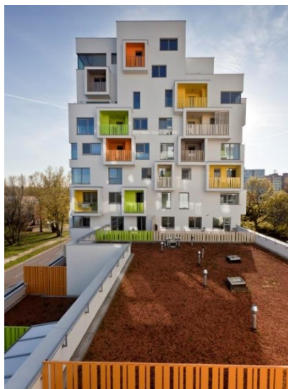
Bytový dom Nový Háj
