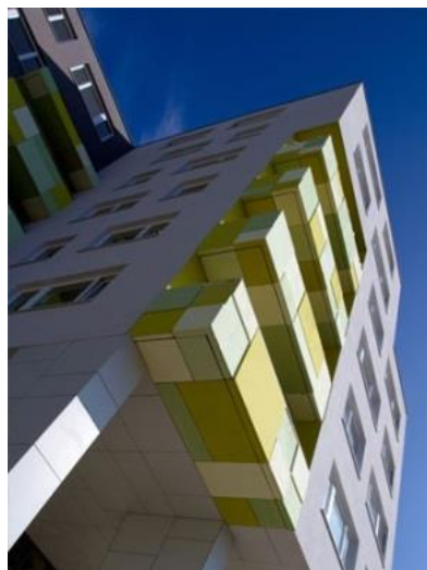
Polyfunkčný objekt Olive
