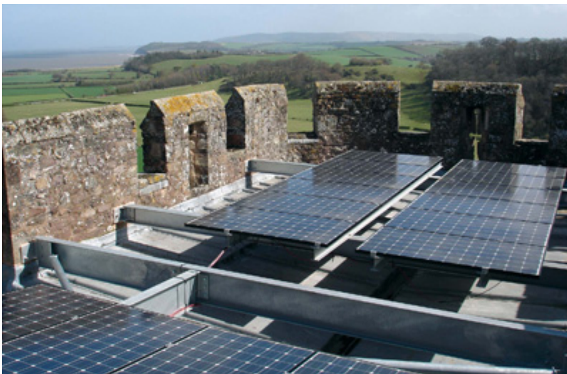
Obr. 27: Pohľad na detail strešnej roviny hradu Dunster, Anglicko s inštaláciou fotovoltických panelov v horizontálnej rovine tak, aby neboli viditeľné z celkových pohľadov na objekt s najvyšším stupňom ochrany. (zdroj: Heritage counts, 2008)
