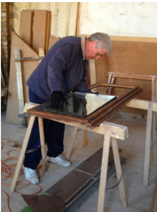
Obr. 20 vľavo: Výmena pôvodných jednoduchých skiel historických okien za izolačné dvojsklo, Obr. 21 vpravo: Detail steny s presklením, stena je zateplená mäkkou konopnou izoláciou s drevovláknitým záklopom a vrstvou hlinenej omietky. (zdroj: OZ Artur)
