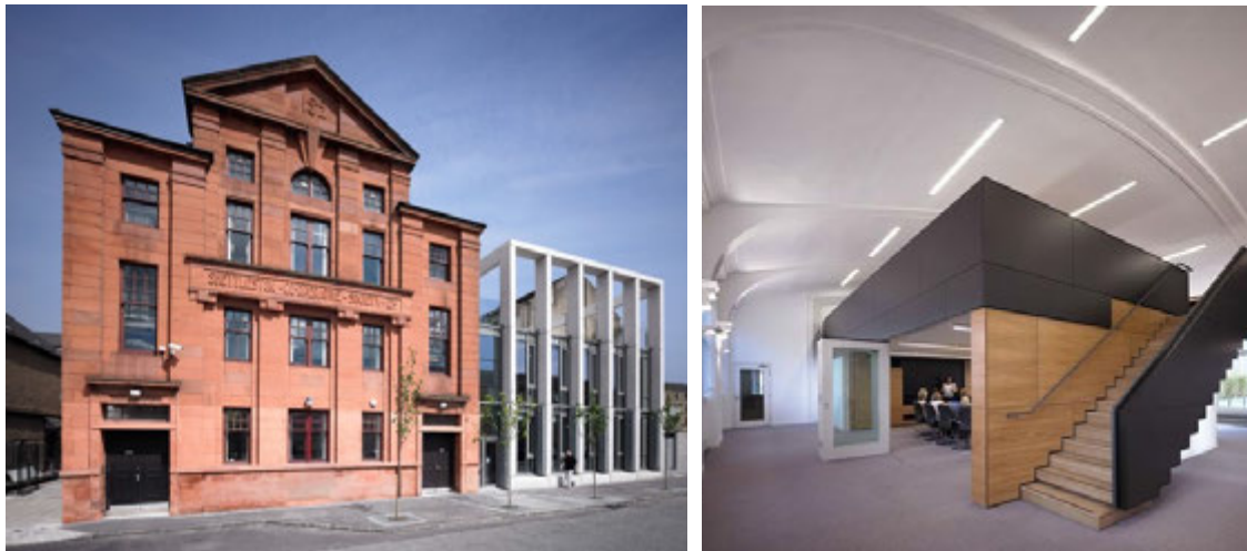
Obr. 23: Vľavo pohľad z exteriéru na administratívnu budovu Cooperative Hall v Glasgowe, architektonická kancelária Elder and Cannon architects, 2009, Obr. 24 vpravo: pohľad do interiéru objektu, novotvar boxu s vlastnými sieťami a mikroklimou, pôvodný interiér je jasne artikulovaný a prezentovaný. (zdroj: internet)
