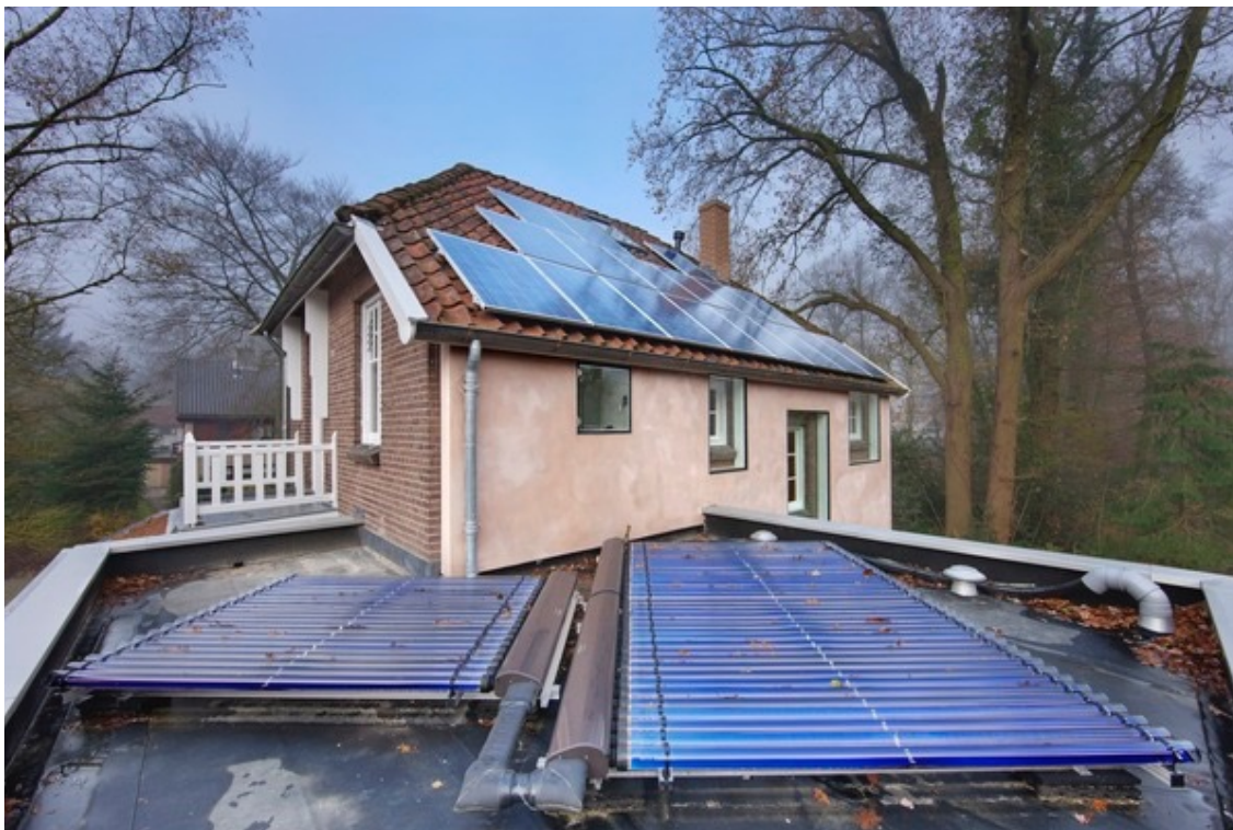
Obr 33: Pohľad na strešnú rovinu prístavby k objektu vily, kde boli inštalované solárne kolektory, na streche historického objektu boli umiestnené fotovoltické panely. Ružová časť objektu predstavuje pridané zateplenie zo strany exteriéru (zdroj: ZECC architects )
