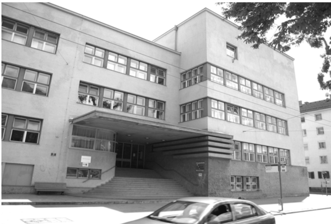
Obr 37: Základná škola, objekt kultúrnej pamiatky monumentalizmu, Innsbruck, Rakúsko. (zdroj: 3encult)
