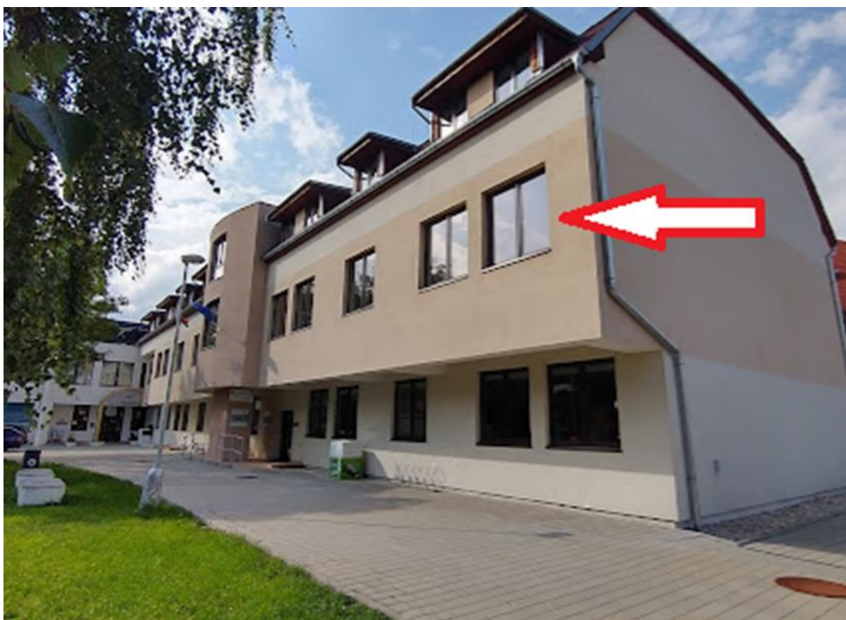
Obr. č. 7 Pohľad od pešej zóny na centrálnu budovu Turčianskej knižnice
