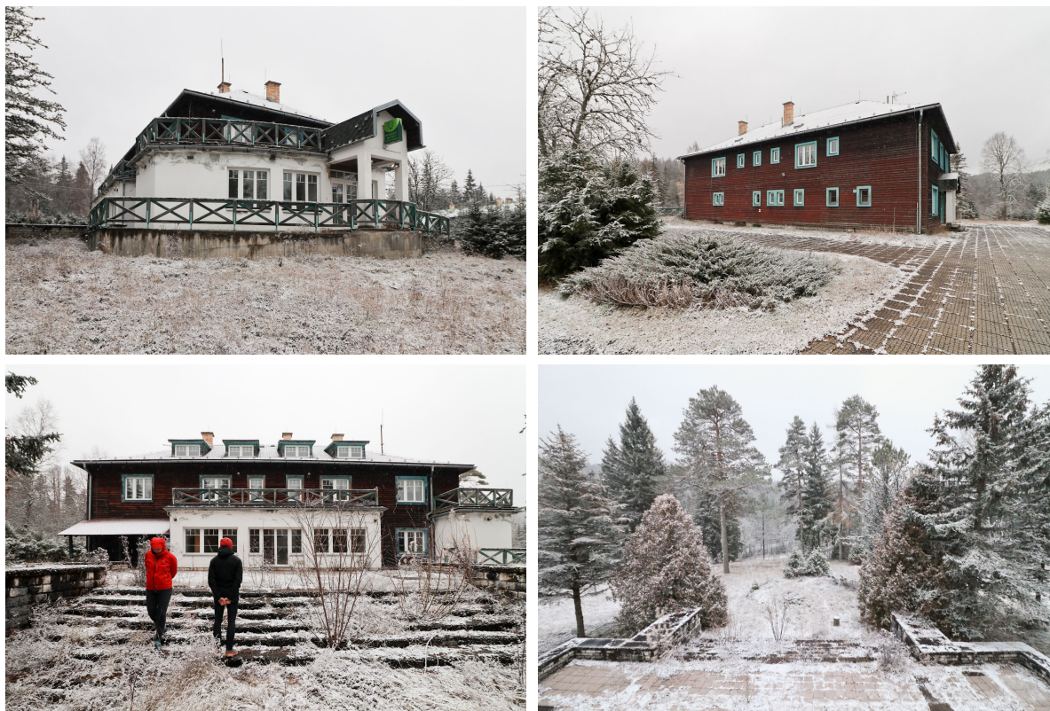
Obr. 5: Objekt z exteriéru
