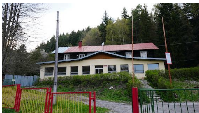
Súčasný stav budovy – Hlavný objekt – administratívna budova
