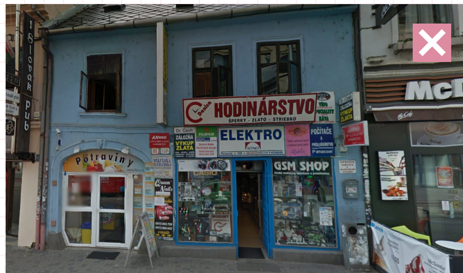
06 Architektúra by sa nikdy nemala strácať pod nánosom vizuálneho smogu. Táto fasáda je zahltená nadmerným množstvom reklamy rôznych tvarov a farieb, pôsobí neusporiadane a chýba jej koncepcia. Bratislava, Obchodná ulica
