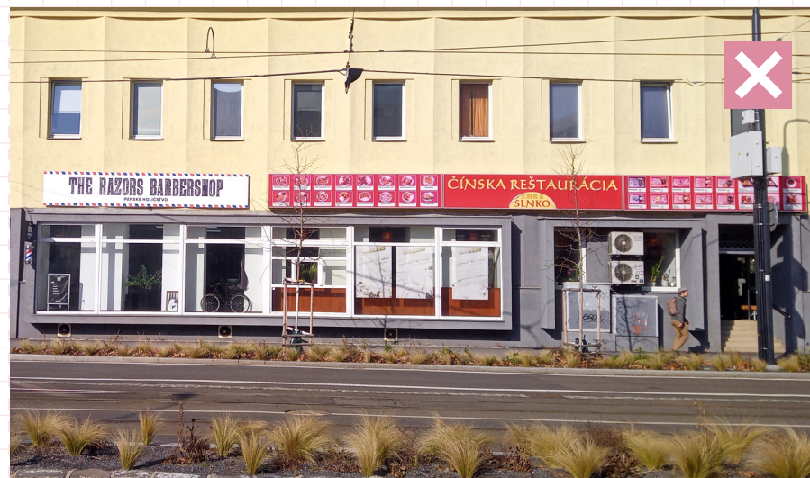
12 Nevhodný príklad vývesného štítu vo forme banneru, resp. tabule umiestnenej dodatočne na fasáde. Okrem toho je nevhodné umiestňovanie reklamy s vyobrazenými produktmi alebo ponukou prevádzky na fasáde. Bratislava, Radlinského ulica
