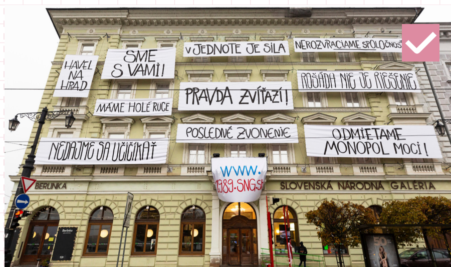
38 Propagácia výročia nezhnej revolúcie na fasáde kultúrnej inštitúcie SNG je žiaduca na podporu kultúry v meste. Ale len v prípade ak reklama, nie je reklamnou stavbou. Ide o prípuštnú formu dočasnej reklamy, ak je vyhotovená spôsobom, ktorý nepoškodí fasádu a je ľahko odstrániteľný po skončení akcie. Bratislava, Nám. L. Štúra
