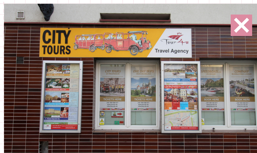
25 Nevhodný príklad. Vitrína na fasáde v Pamiatkovej rezervácii Bratislava môže slúžiť len na propagáciu ponuky stravovacích zariadení alebo programu kultúrnych inštitúcií. Okrem toho vitríny by mali byť umiestnené vedľa vstupu. Dané umiestnenie medzi oknami narúša kompozíciu fasády. Bratislava, Panská ulica
