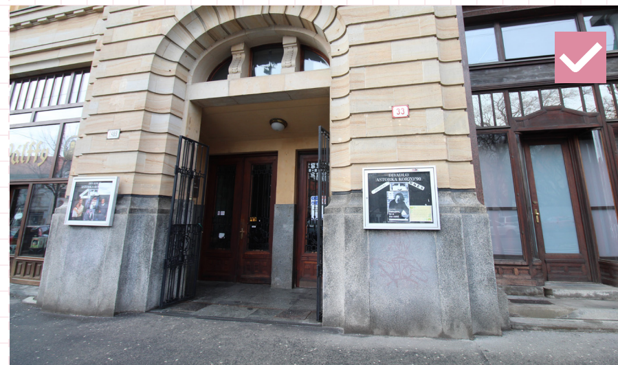
24 Príklad vyhovujúceho dizajnu vitrín umiestnených na fasáde na propagáciu programu divadla. Kompozične by bolo vhodnejšie umiestniť vitríny nad úrovňou sokla (tak aby neprekryvali dve farebné rozhrania). Bratislava, Námestie SNP
