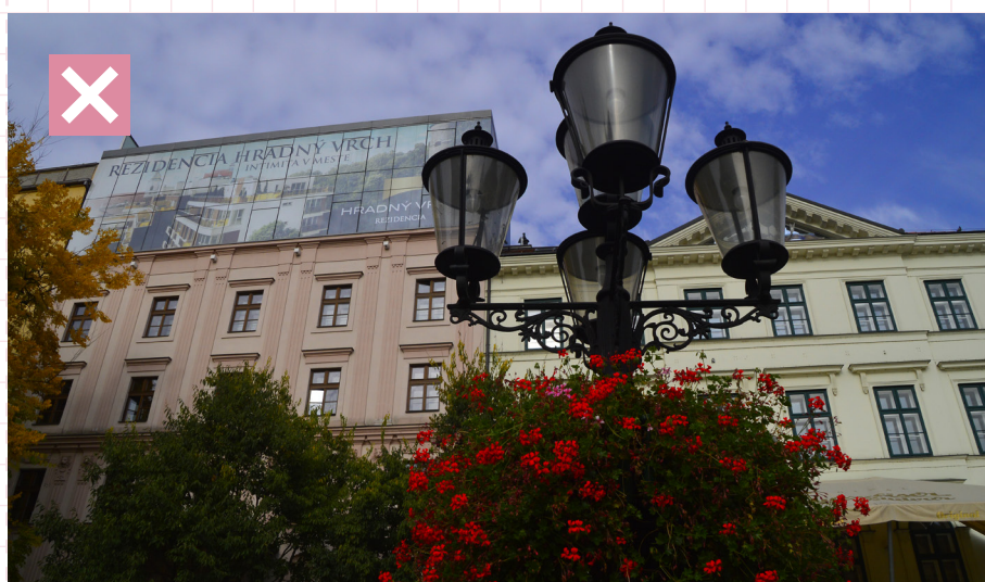
05 Nevhodný príklad reklamy, ktorá dominuje fasáde, nepodriada sa jej mierke, kompozícii a celoplošne pokrýva fasádu. Bratislava, Hviezdoslavovo námestie
