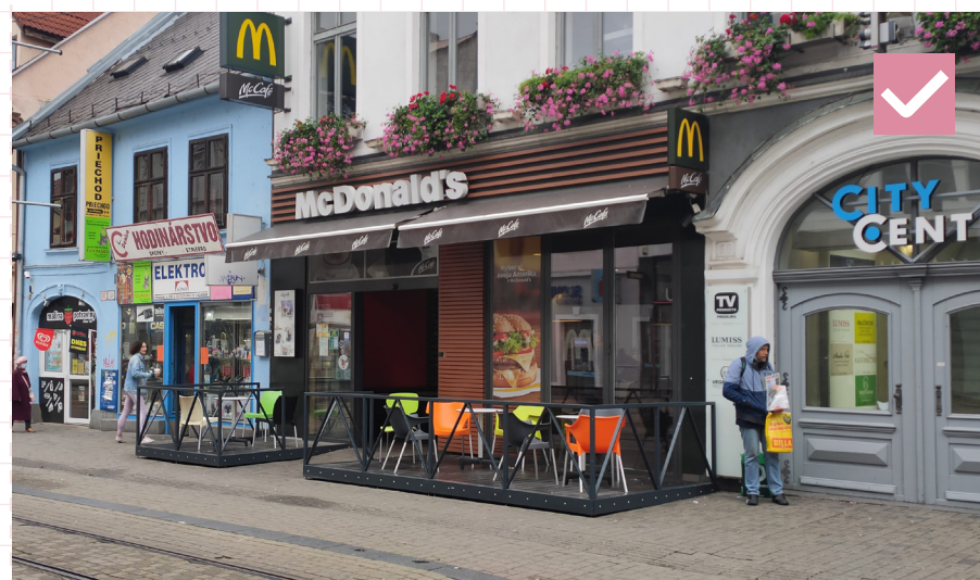
31 Vhodný príklad s reklamným nápisom na markíze, ktorý je decentný a v neutrálnych farbách. Ostatné reklamné prvky by bolo vhodné redukovať. Na fasáde stačí jedno označenie nápisom a nie je vhodné umiestňovať ďalšie výstrče s označením. Bratislava, Obchodná ulica
