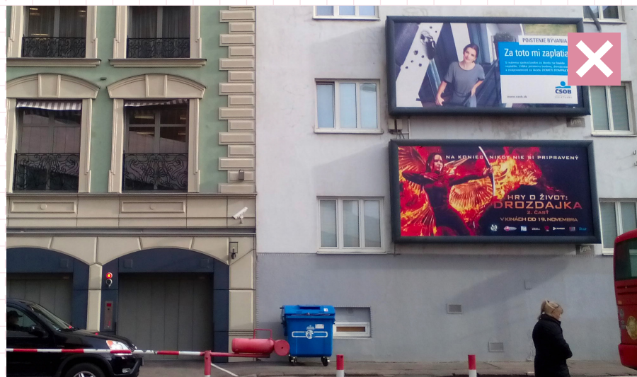
36 Betónová konštrukcia, na ktorej je ukotvená reklamná plocha, nesmie zaberat priestor nad terénom. Bratislava, Rajska ulica
