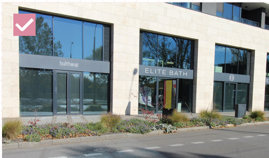
03 Vhodné riešenie fasády. Na fasáde sa nenachádzajú iné reklamné prvky okrem označenia prevádzky, ktoré tvorí decentnú súčasť architektonického riešenia fasády. Bratislava, Nábrežie armádného generála Ludvíka Svobodu
