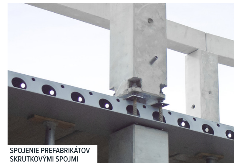
KOTEVNÉ SKRUTKY NA PRÍPOJENIE PRIEBEŽNÝCH NOSNÍKOV UMIESTNENÝCH NA BETÓNOVÉ STĽPY
