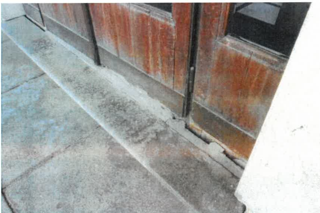
Foto č. 8 Čelná fasáda – hlavní vstup do idvadla – poruchy podláh a vstupných dverí
