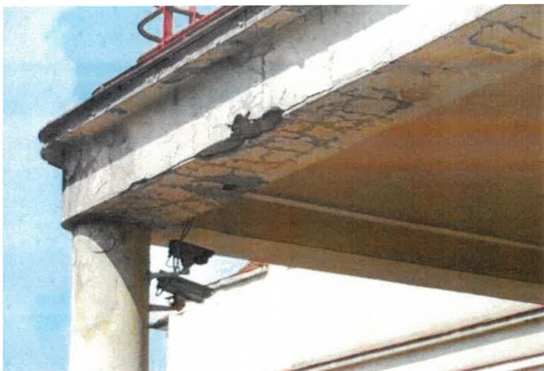
Foto č. 10 Čelná fasáda – vstup do idvadla – poruchy kamenných múrikov
