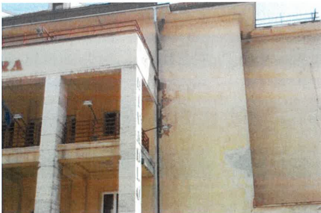
Foto č. 6 Čelná fasáda – hlavný vstup do idvadla – statické poruchy – pokles prievlaku medzi hlavnými piliermi.
