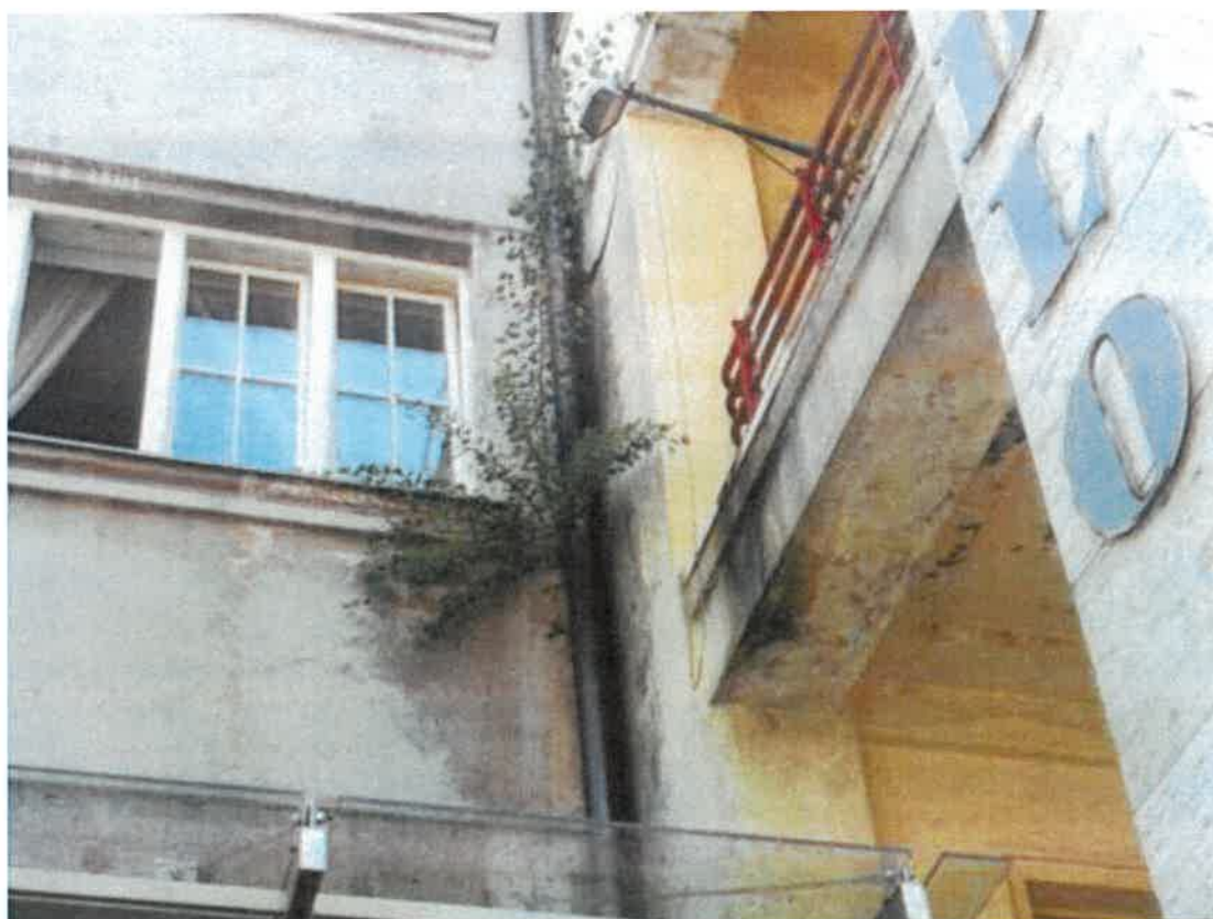
Foto č. 12 Strešná terasa – poruchy strešnej krytiny a klampiarských výrobkov striech
