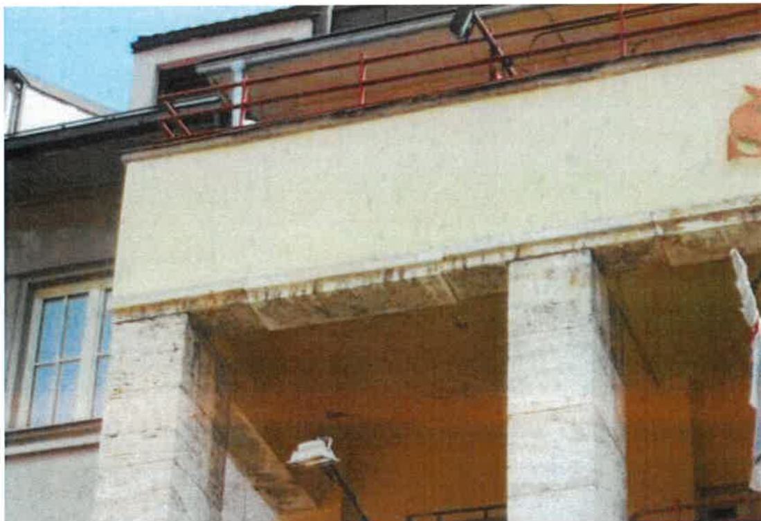
Foto č. 6 Čelná fasáda – hlavný vstup do idvadla – statické poruchy – pokles prievlaku medzi hlavnými piliermi.
