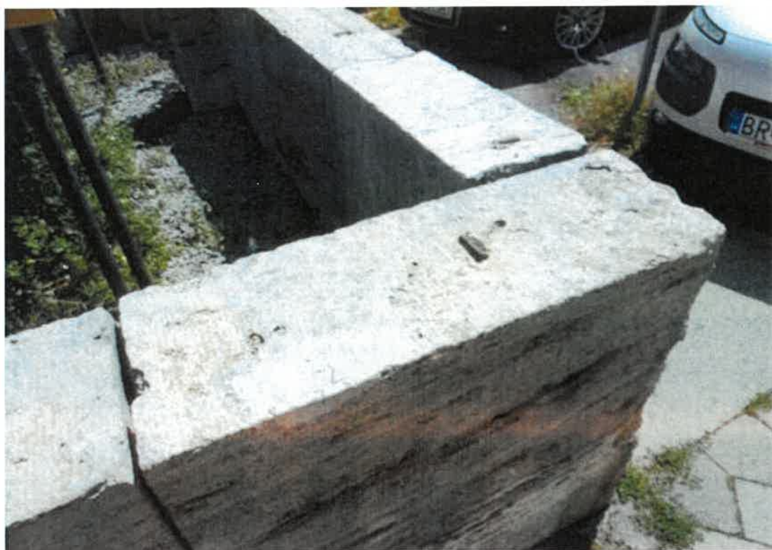
Foto č. 10 Čelná fasáda – vstup do idvadla – poruchy kamenných múrikov
