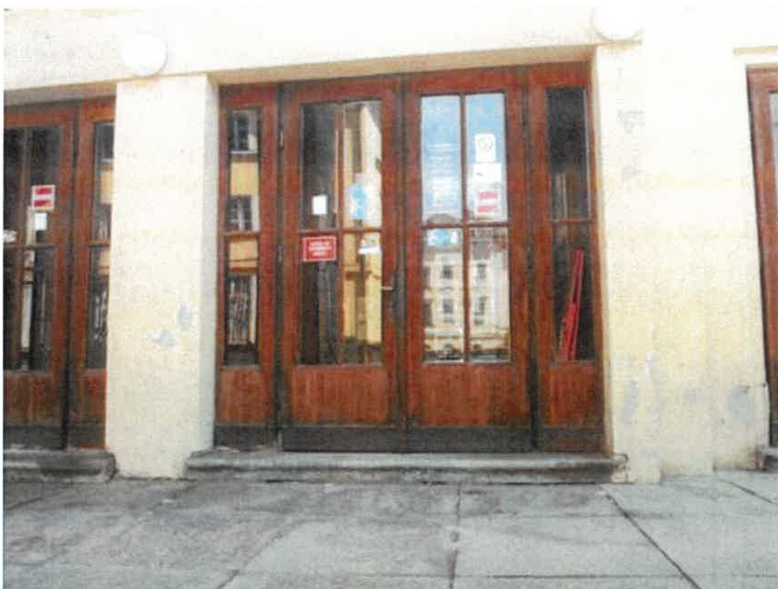
Foto č. 8 Čelná fasáda – hlavní vstup do idvadla – poruchy podláh a vstupných dverí
