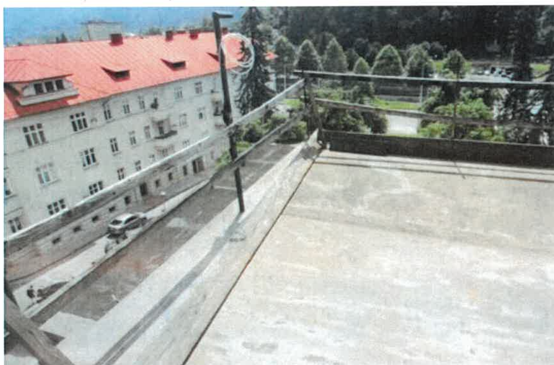
Foto č. 12 Strešná terasa – poruchy strešnej krytiny a klampiarských výrobkov striech
