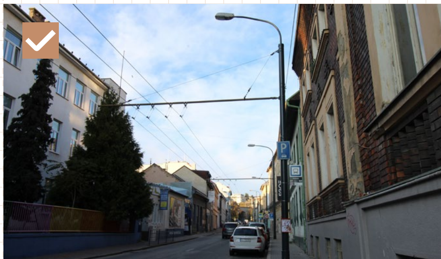
20 Vhodný príklad integrácie viacerých funkcií na jeden stožiar – v tomto prípade ja na jednom stožiaru osadené verejné osvetlenie, trolejové vedenie, označník zastávky MHD informačná tabuľa MHD a dopravné značenie. Prvky (okrem informačnej tabule) sú vhodne zjednotené antracitovou farbou. Bratislava, Karpatská
