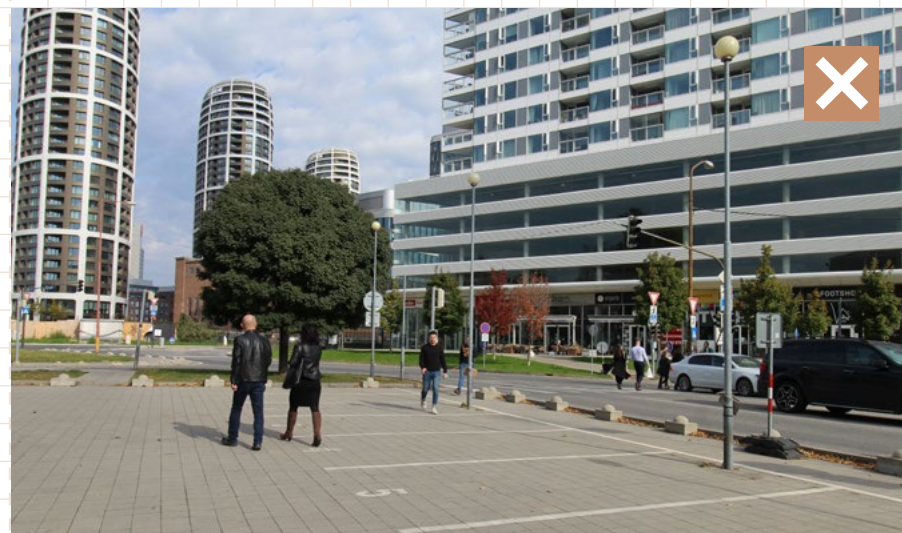
33 Nevhodne umiestnené osvetlenie na veľkokapacitnom parkovisku v nevhodnom dizajne. Stožiare sú príliš nahusto a nevhodne umiestnené uprostred parkovacieho miesta. Bratislava, Pribinova
