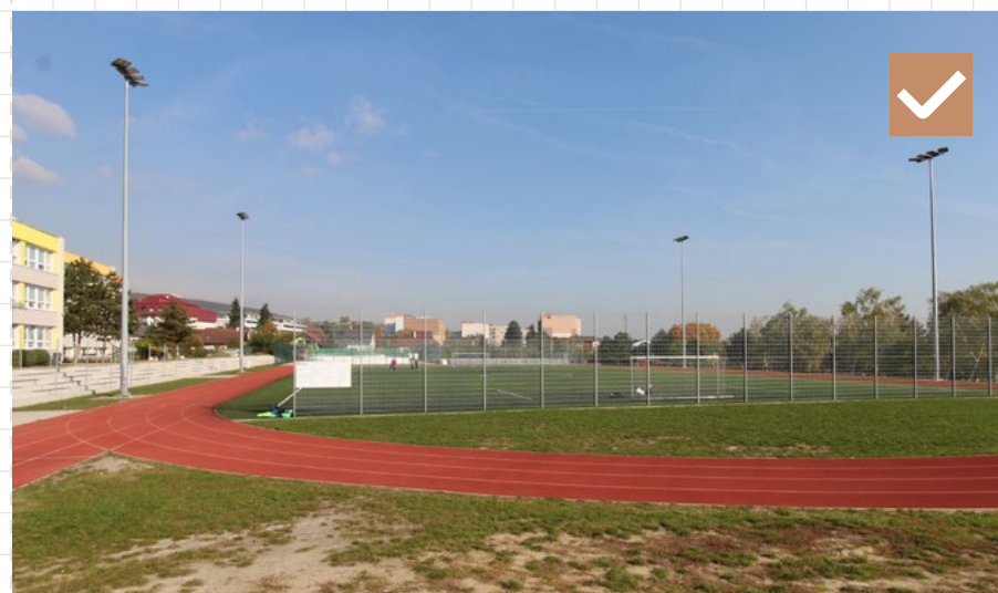
35 Vhodné osvetlenie športoviska – výškové stožiare umiestnené v rohoch športoviska. Bratislava, ZŠ Tbiliská
