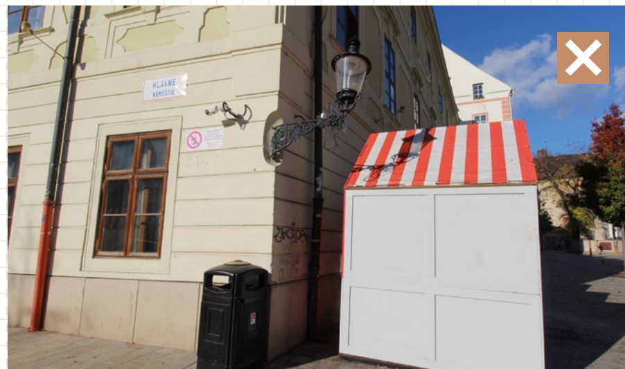
27 Konzola VO je umiestnená veľmi nízko, čím môže dojsť k jej poškodeniu vozidlami zásobovania, prípadne vozidlami údržby. Bratislava, Hlavné námestie
