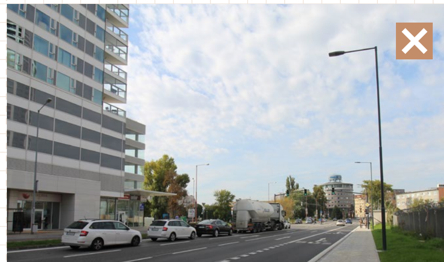
21 Nevhodný príklad, kde v prípade výmeny VO na jednej strane ulice nebolo vymenené aj osvetlenie na opačnej strane. Dôsledkom je nejednotný vzhľad ulice z dôvodu rozdielného dizajnu a farby svietidiel. Bratislava, Landererova
