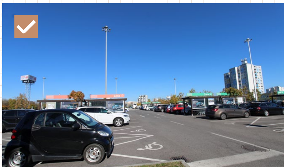
32 Vhodné riešenie osvetlenia veľkokapacitného parkoviska výškovými stožiarňami umiestnenými v menšej hustote. Bratislava, Panónska cesta
