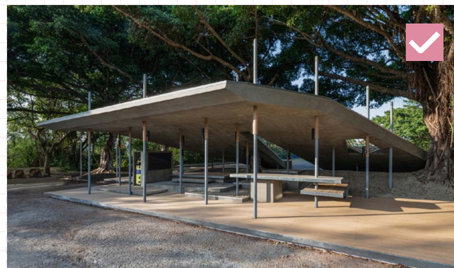
25 Originálne riešenie prekrytia priestoru pre čakajúcich v prírodnom prostredí v blízkosti kampusu vhodne zapadá do prostredia. Prestrešenie poskytuje dostatočný komfort čakajúcim, má integrovaných viac možností posedenia, automat na lístky, ale tiež informačnú vitrínu. Použitie materiály: drevená podlaha a posedenie, kovová konštrukcia a betónová konštrukcia vegetačnej strechy. Pochôdzna strecha pokrytá trávou vytvára ďalšie možnosti nielen na čakanie, ale aj na posedenie a relax. Taiwan, Hsinchu
