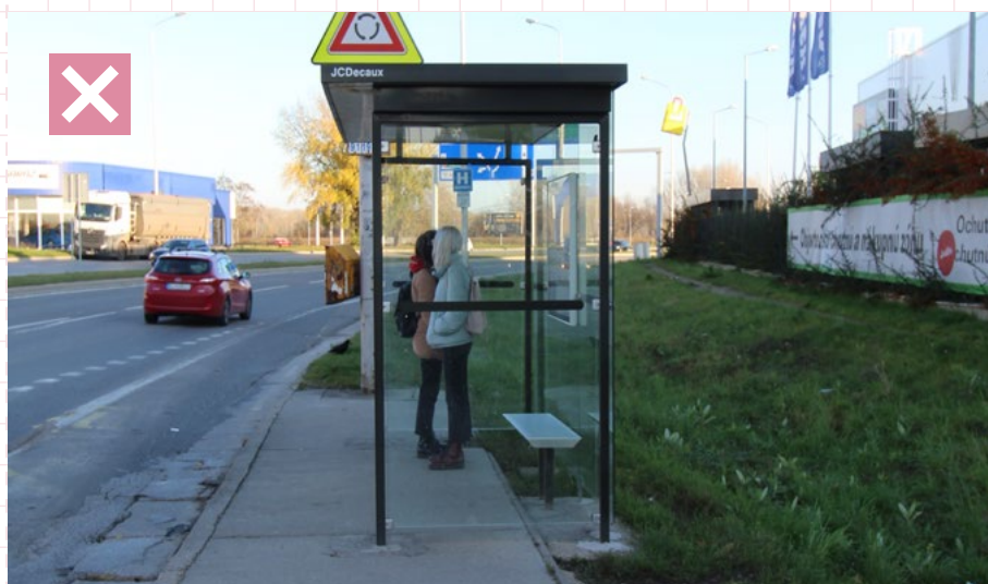
39 Nevhodný príklad prístrešku umiestneného v zeleni s chýbajúcou vybudovanou nikou. Prístrešok síce zachováva minimálnu voľnú šírku nástupištia ale chýba vybudovaná nika dostatočných rozmerov so spevnenou plochou pod prístreškom. Bratislava, zastávka Jasovská
