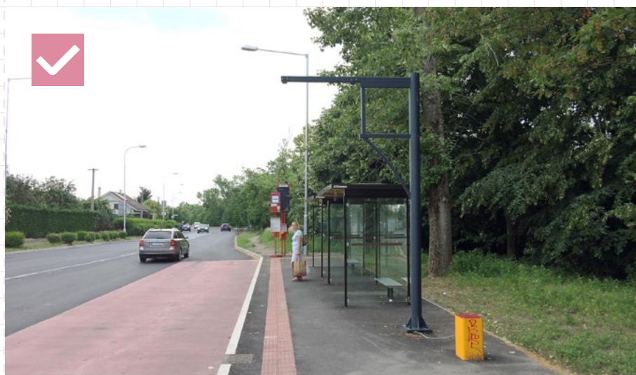
40 Príklad umiestnenia prístrešku na samostatnom autobusovom nástupišti. Samostatné nástupišťe nie je zároveň chodníkom, čím je možné budovať ho ujšie ako v prípade spojenia funkcie s chodníkom. Bratislava, zastávka Vrančovičova
