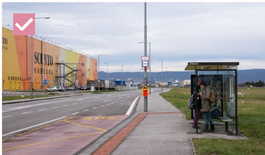
38 Príklad prístrešku umiestneného vo vhodne vybudovanej nike v zeleni. Nika je vhodne vytvorená mimo chodníka, čím prístrešok netvorí bariéru v pohybe chodcov po chodníku. Zároveň je okolo niky vhodne vytvorená spevnená plocha v šírke približne 0,5 metra z dôvodu pohodlného vykonávania údržby prístrešku. Bratislava, zastávka Pharos
