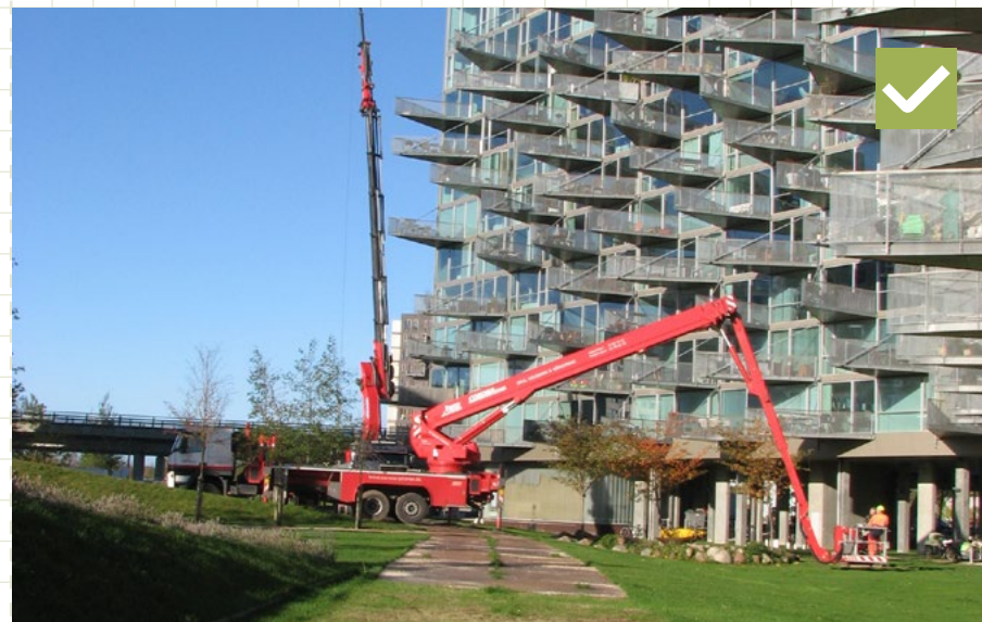
10 Prejazd vozidla po oceľových platniach, záťaž je roznášaná na väčšiu plochu Kodaň, Dánsko
