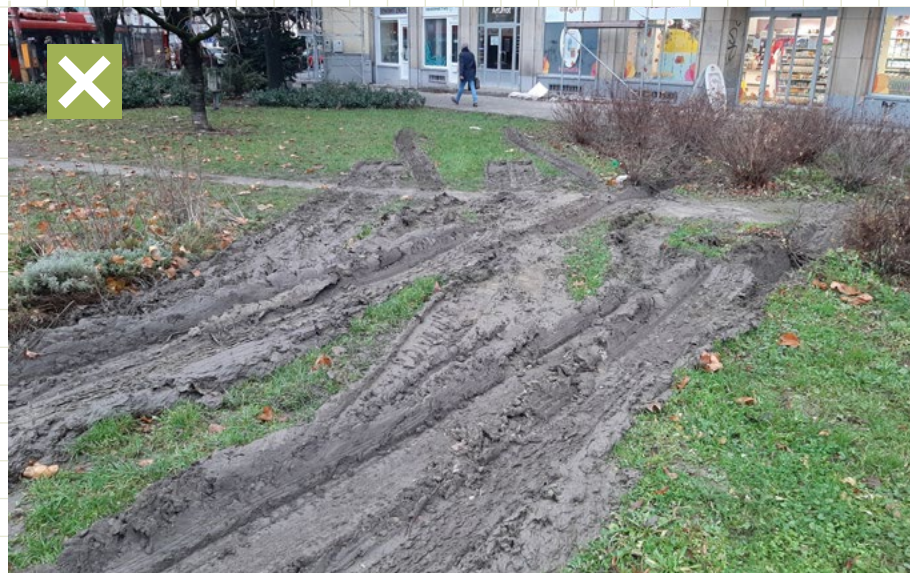
09 Pri stavebných prácach neboli použité vozňové dosky alebo panely na prejazd ťažkej techniky, vďaka ktorým by sa predišlo zhutneniu a devastácii pôdneho horizontu. Bratislava, Križna ulica
