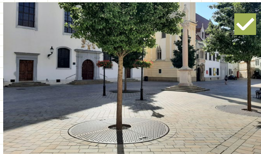
14 Trvalá vodorovná ochrana stromov pred pojazdom a parkovaním vozidiel pri potrebe pochôdznej plochy pri strome - oceľová mreža. Františkánske námestie Bratislava
