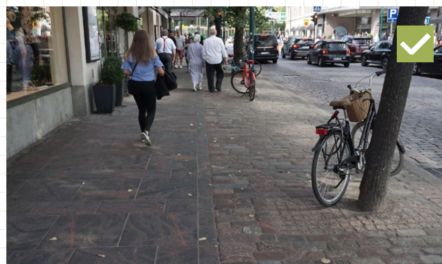
16 Trvalá vodorovná ochrana stromov pred pojazdom a parkovaním vozidiel pri potrebe pochôdznej plochy pri strome - kamenná vodopriepustná dlažba. Helsinki Fínsko
