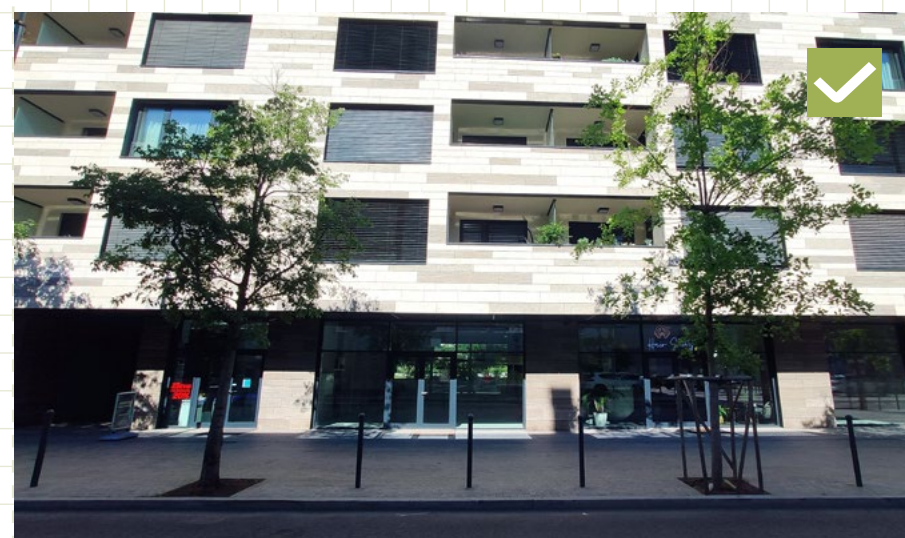
53 Vhodný príklad osadenia stĺpikov vo vzťahu k stromom ako zábrany proti vjazdu vozidla. Bratislava, Radlinského ulica
