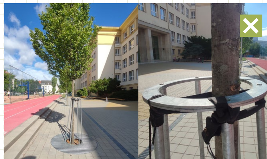
67 Nevhodný príklad ochrany stromu, ktorá je osadená v šikmom povrchu, z dôvodu čoho je stabilizačná ochrana vyosená a poškodzuje mladú kôru kmeňa. Bratislava, Novohradská ulica.
