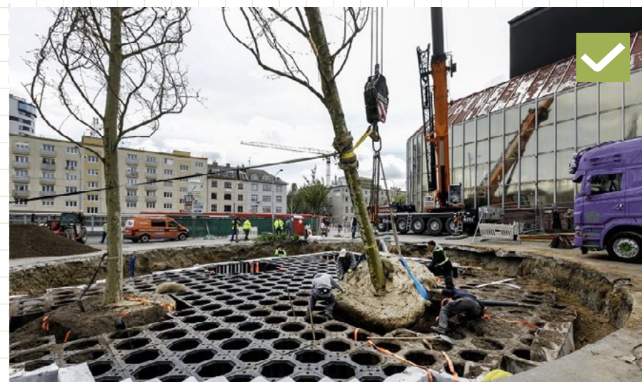
69 Vhodný príklad výsadby stromov v kombinácii s prekoreňovacími bunkami. Bratislava, Trnavské mýto
