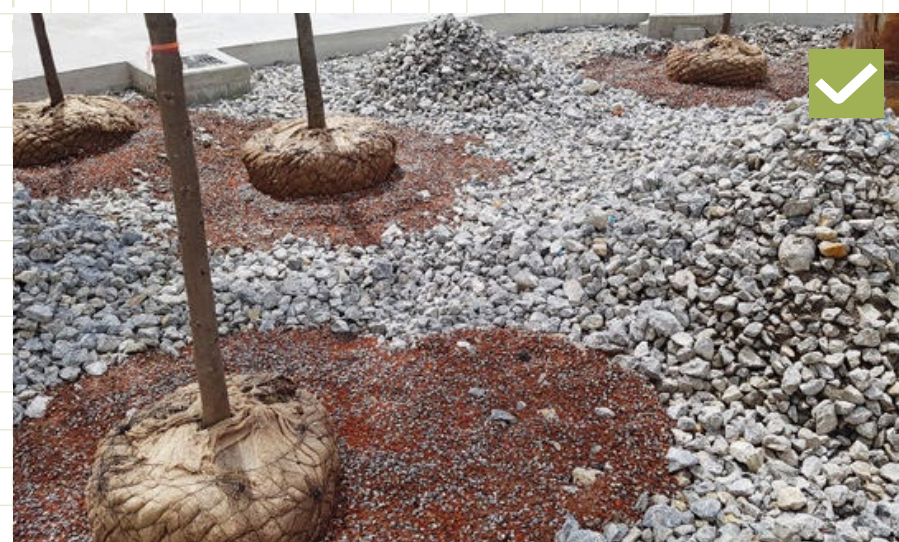
70 Príklad výsadby stromov v štrukturálnom substráte.
