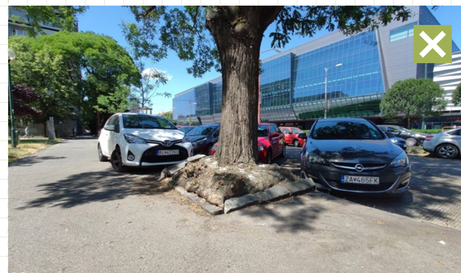
72 Dôsledok zle založenej výsadby - abnormálne hrubnutie kmeňa. Bratislava, Trnavská cesta
