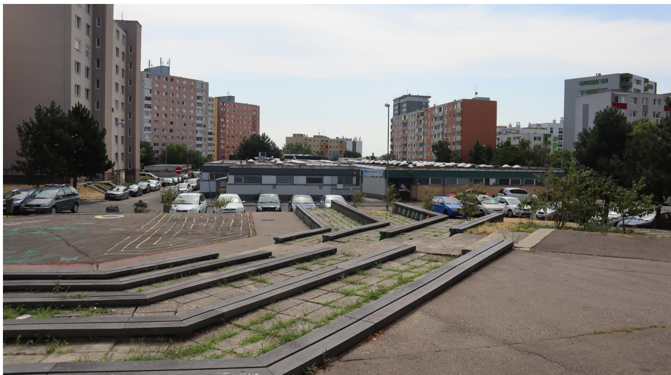
Obr. 4 Fotografie súčasného stavu - exteriér
