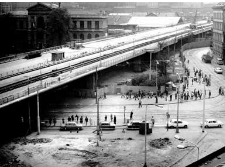
Výstavba severojižní magistrály na Firenci v 70. letech 20. století
