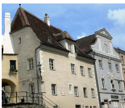
Konzervačnou metódou s neutrálnou prezentáciou vývojových fasádnych etáp odlišením v štruktúre omietok. Architektúra z lokality svetového dedičstva -- údolie Wachau, Rakúsko.
