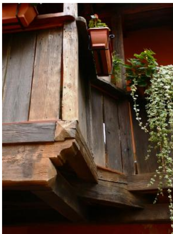
Baroková pavlač z pol. 18. storočia bola zachovaná a konzervovaná. Z funkčných a technických dôvodov bolo odstránené exteriérové schodisko na poschodie, ktorého prvky boli použité v interiéri.
