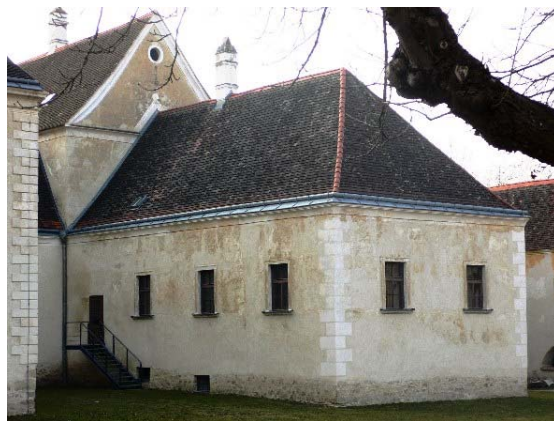
Konzervačnou metódou -- tradičnými materiálmi a technológiami reštaurované fasády kláštora kartuziánov v Mauerbachu, Rakúsko.
