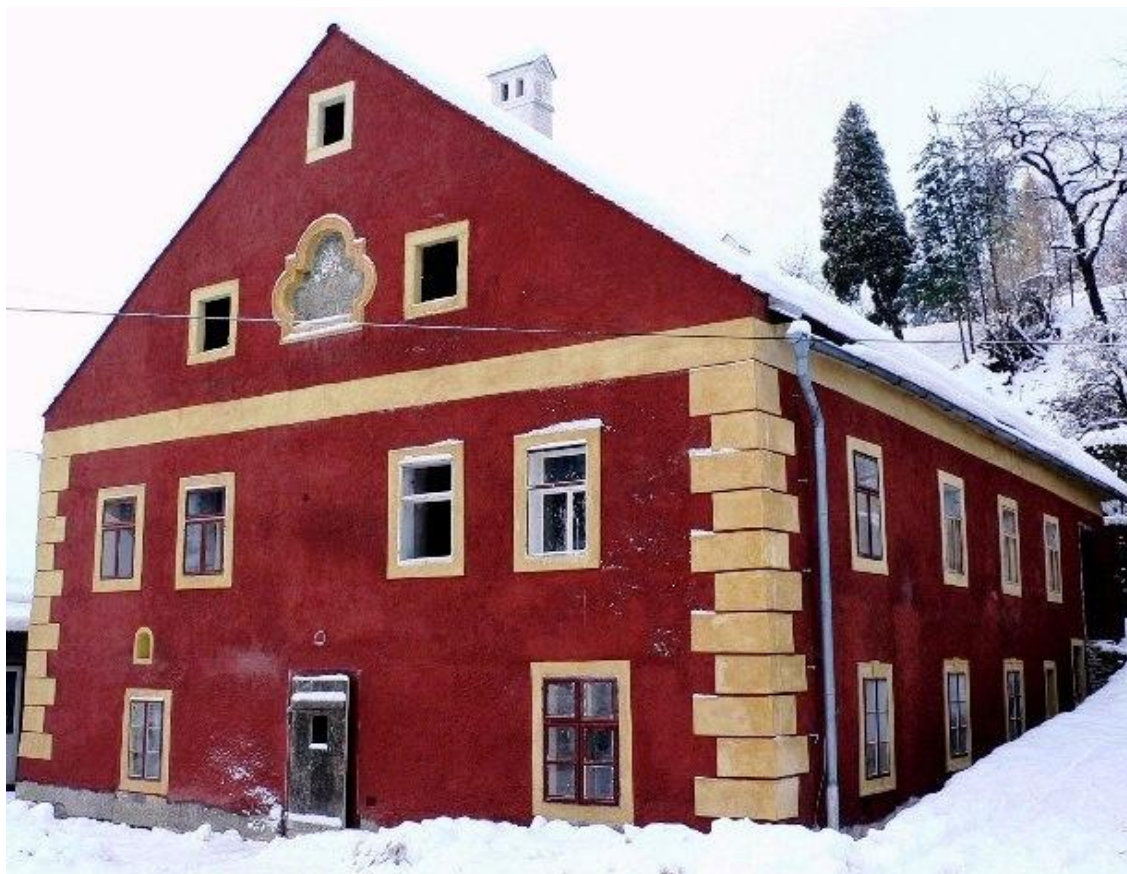
Realizácia obnovy fasády tradičnými materiálmi a technologickými postupmi (vápenná technológia omietok a hlinka do vápna pre povrchovú úpravu).
