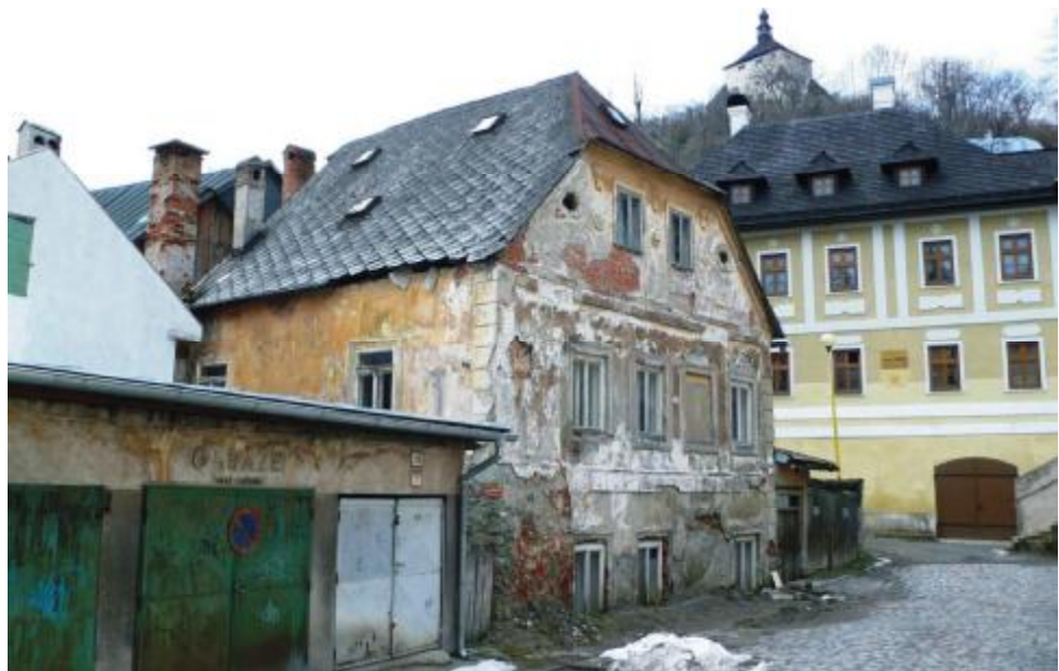
Pohľad na dom začiatkom 20. storočia a v roku 2006. Okrem celkového stavebno-technického stavu domu, je silne narušené historické prostredie okolitej zástavby (garáže).
