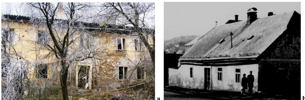
a) Pod Červenou studňou 11 – pravdepodobne dom zo 17.-- 18. storočia, zbúraný po dlhodobom zanedbaní údržby koncom 90. rokov 20. storočia. b) Bývalá pekárň -- Eiseleovský dom na Dolnej ulici bol cielene zbúraný už po zaradení mesta na Zoznam svetového dedičstva... Foto: Katarína Vošková, Margita Kováčsová.
