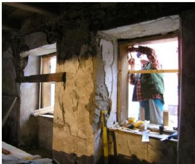
Oprava pôvodných okien na mieste (pohľad z interiéru a exteriéru).
