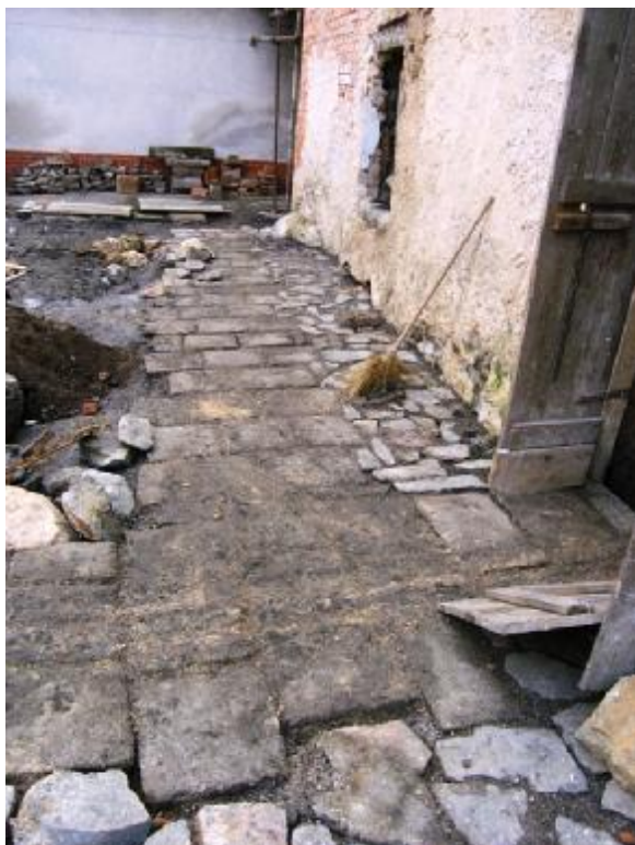
a) Dláždenie dvora kamennou dlažbou z ryolitu a lomovým kameňom. b) Stav drevených trámových stropov v interiéri na poschodí. c) Kamenný klenák, zo zaniknutého vstupného portálu.
