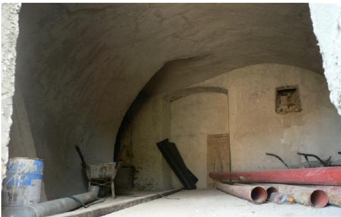
Pohľad do zaklenutého priestoru zo severnej strany na prízemí. Pôvodné omietky boli odstránené a nahradené priemyselne vyrábanými cementovými omietkami. Strata autenticity materiálu, technológie a spiritu.
