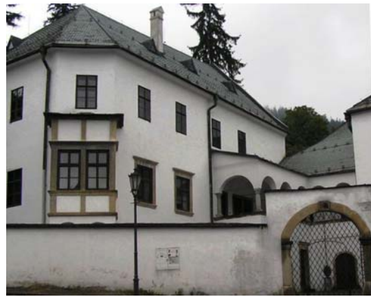
Belházyho dom na Radničnom nám. č. 1 – pred a po obnove. Pôvodné vápenné omietky s nástennými maľbami na fasáde boli nenávratne zničené počas obnovy v 80. rokoch 20. storočia a nahradené cementovou technológiou.
