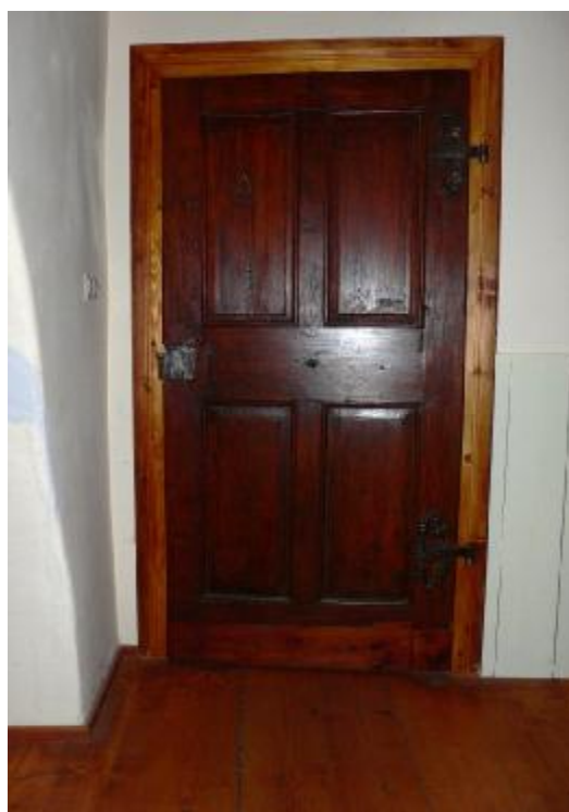
Pôvodné dvere v miestnostiach na poschodí boli konzervované a zachované. Takisto aj drevené doskové podlahy v miestnostiach.
