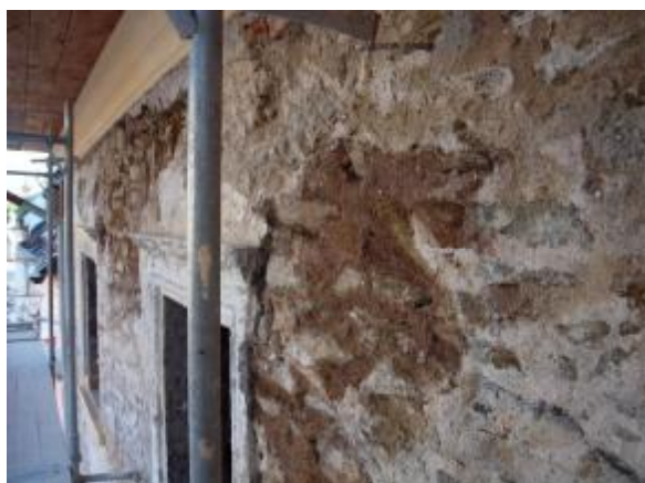
Otlkanie klasicistickej щukovej výzdoby znamenalo poщkodenie aj starších оштукатурочных vrstiev (бароквová s щiernymi pásmi, ренессанщная, щkorej podoba sa išla реконщструovať, щотická s илузійным квáдрованієм). Vpravo – одhalený ренессанщный надщветлік над ренессанщным щтупом, дощtedy щачоване культурне оштукатурочные vrstvy okolo надщветліка s ренессанщной декорацией су одщраћене. (Realizácia: щеставращор s лиценщией).
