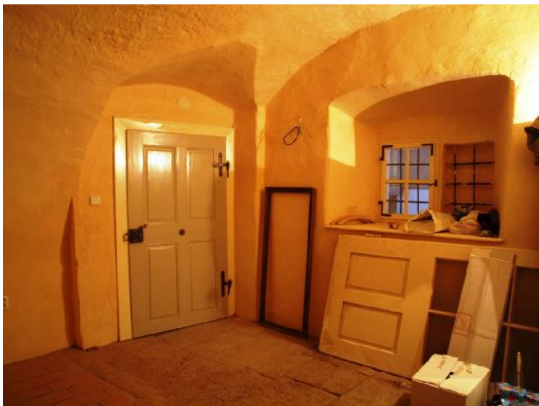
Renesančný priestor na poschodí po pamiatkovej obnove. Zachovaná kamenná dlažba z andezitu, zachované pôvodné omietky, ošetrované vápenným náterom.
