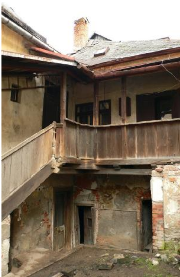
Baroková pavlač (z pol. 18. stor.) v tvare „L“ popri dvorových fasádach domu a detail tesárskych výtvarne riešených konštrukcií pavlače.
