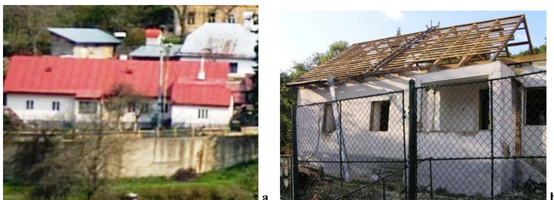
Cielene zbúraný dom v užšom historickom centre na Hornej ružovej ulici č. 8 a 9. a) Stav domu pred zbúraním. b) „Odstrojenie“ domu od detailov tesne pred zbúraním. Foto: Katarína Vošková.
