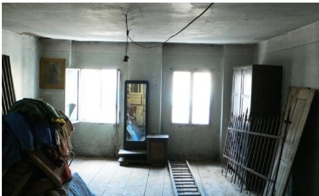
Historická podkrovná miestnosť, orientovaná do štítu strechy, po stranách sú priechodné chodby pre kontrolu stavu krovu a strešnej krytiny.
