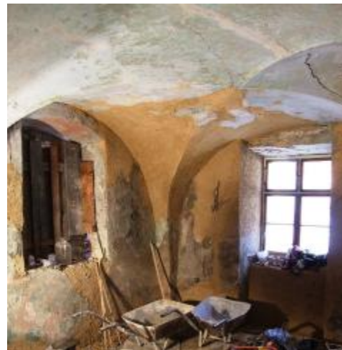
Oprava staticky narušenej klenby na prízemí – stav počas prác a po ukončení stabilizácie klenbenej konštrukcie.
