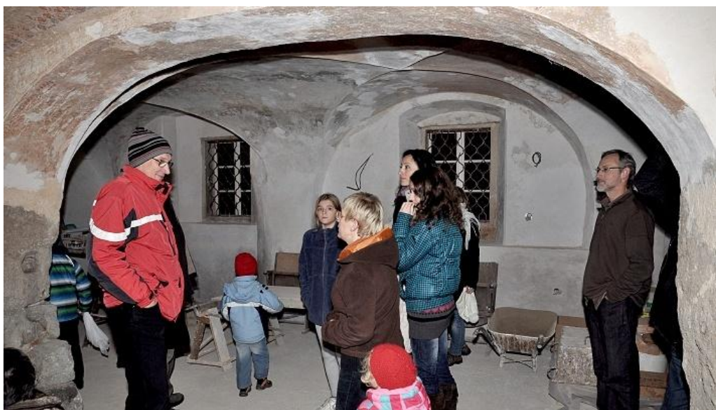
Zaklenutý priestor prízemia – niekdajšia kováčska dielňa. Po konsolidácii a doplnení omietok, zatiaľ bez povrchovej úpravy.
