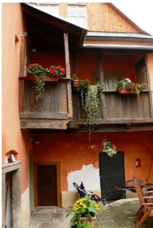
Baroková pavlač z pol. 18. storočia bola zachovaná a konzervovaná. Z funkčných a technických dôvodov bolo odstránené exteriérové schodisko na poschodie, ktorého prvky boli použité v interiéri.
