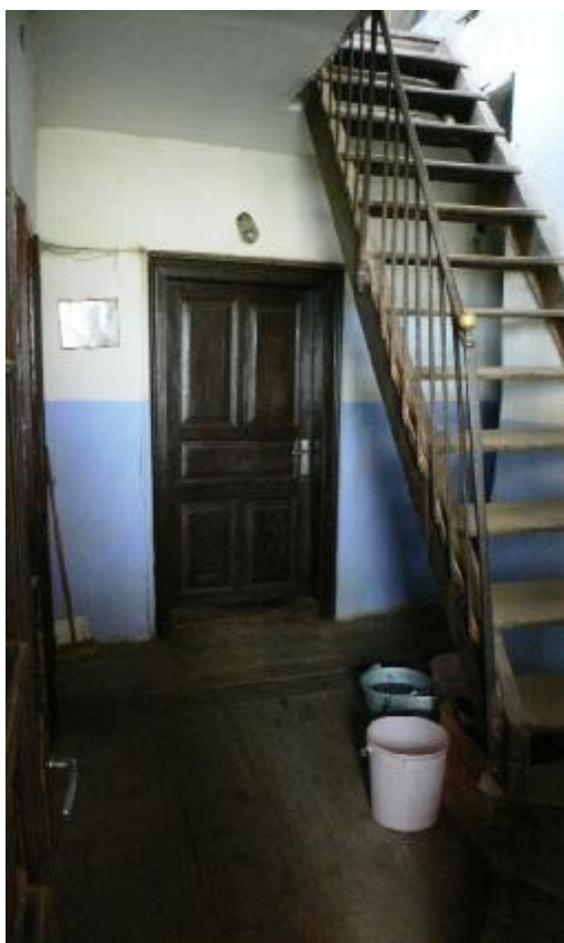
Drevené schodisko z poschodia do podkrovia s kovovým zábradlím s mosadznými detailmi.
