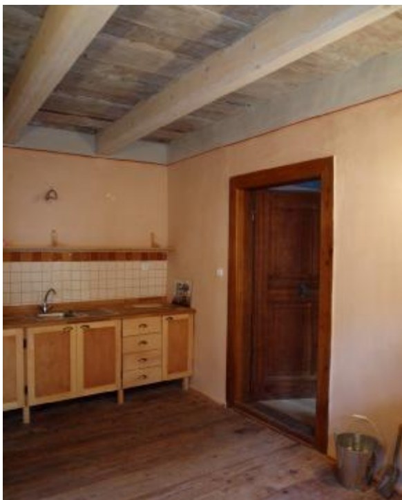
Priestory na poschodí po pamiatkovej obnove. Autenticita priestorov je dosiahnutá rešpektovaním pôvodných materiálov: drevené alebo tehlové podlahy, remeselne opravené historické dvere, stropy, vápenné omietky a vápenné nátery.
