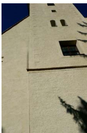
Konzervačnou metódou s neutrálnou prezentáciou vývojových fasádnych etáp odlišením v štruktúre omietok. Architektúra z lokality svetového dedičstva -- údolie Wachau, Rakúsko.
