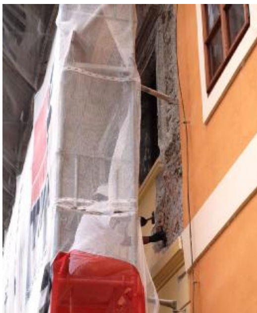
a) Otlkanie klasicistickej fasádnej úpravy, ktorá chránila zakonzervované staršie omietkové vrstvy. b) Fragменты бароквовой оштукатурки с маляванной выдубой пощас одстраћования оштукатурки перед реставрацией ренессансной подобы фасады.
