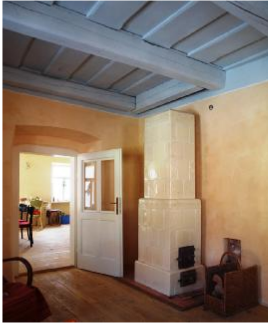
Priestory na poschodí s obnovenými dlažbami, drevenými stropmi a keramickými kachľovými pecami.
