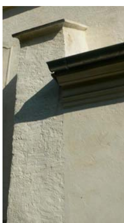
Konzervačnou metódou s neutrálnou prezentáciou vývojových fasádnych etáp odlišením v štruktúre omietok. Architektúra z lokality svetového dedičstva -- údolie Wachau, Rakúsko.
