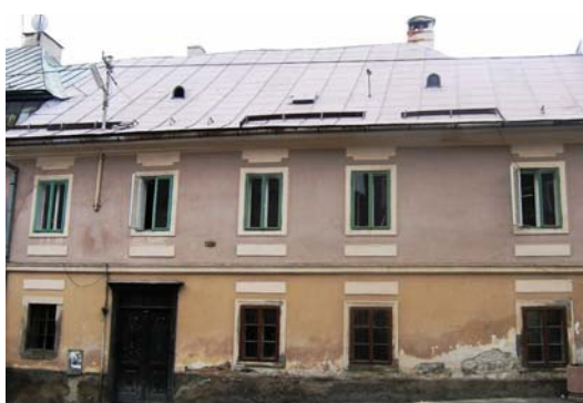
Čelná fasáda – pred obnovou
