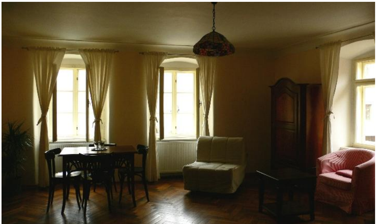
Miestnosť na poschodí, so zachovanou fabiónovou rímsou, s okennými nikami so segmentovými záklenkami. Boli zachované aj parkety z 1. polovice 20. storočia.
