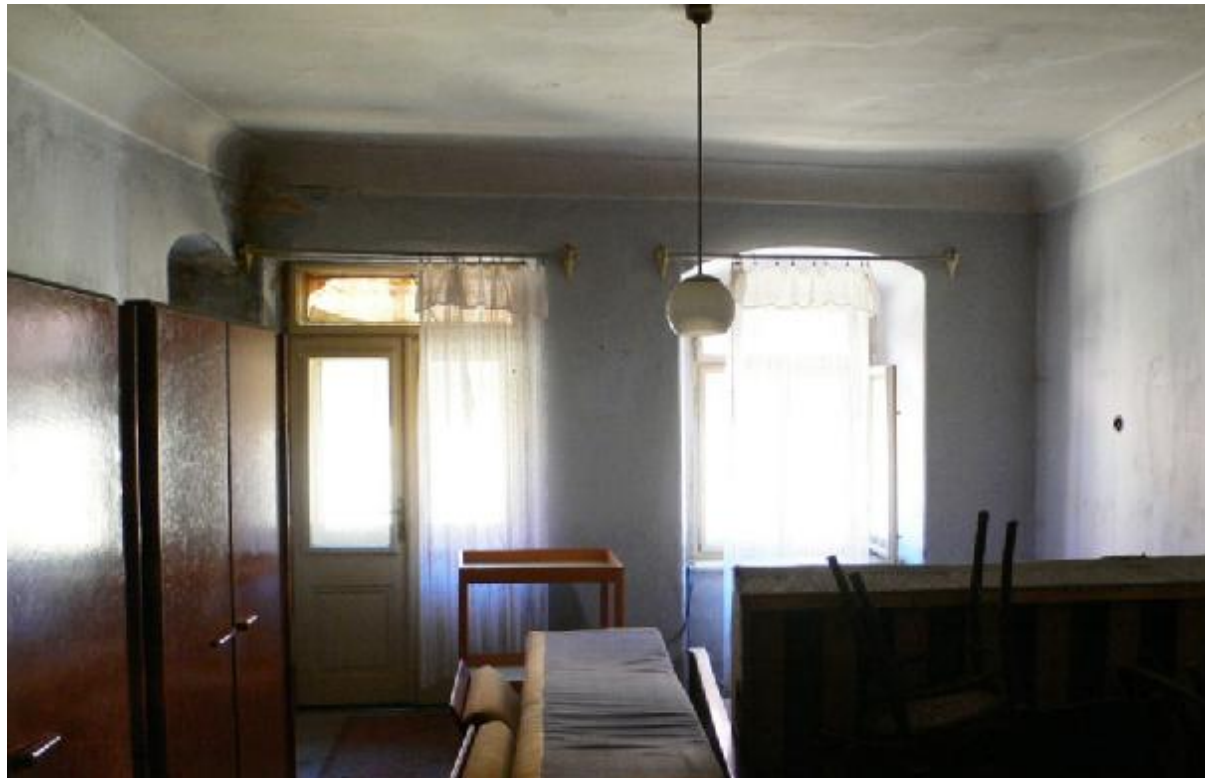
Miestnosť na poschodí, orientovaná do dvora s dvojkřídlovými dverami na pavlač a okennou nikou so segmentovým záklenkom. V rohoch miestnosti je typicky baroková fabiónová rímsa.
