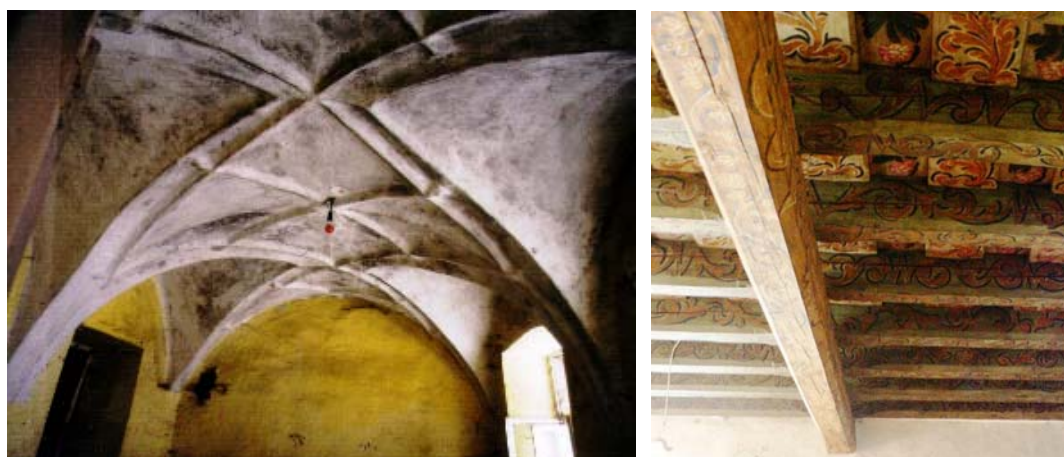
Hodnoty výtvarné, veku, originálu a konštruktívneho riešenia sa stretávajú aj v technickom riešení, materiáli a architektonickom výraze vodorovných konštrukcií. Foto: Katarína Vošková.
