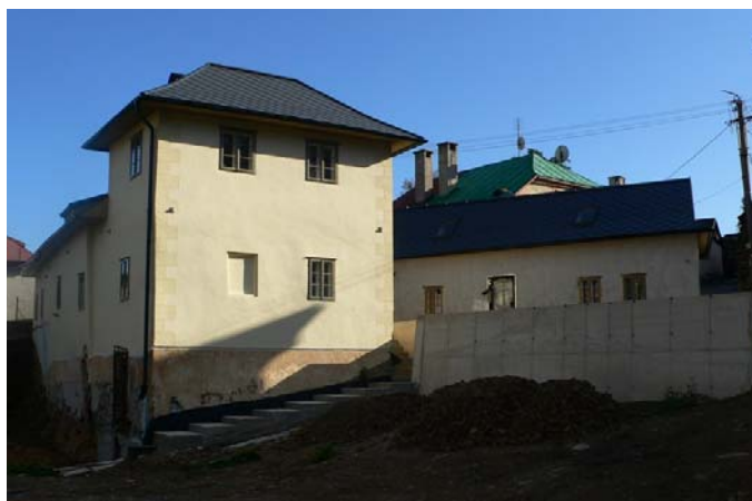
Pohľad na nárožie domu v priebehu obnovy a po obnove. Z priebehu obnovy je zrejmé, že pôvodne drevená zrubová konštrukcia bola odstránená a nahradená novou tehlovou. Zmena tvaru strechy na valbovú nad vežovou časťou degraduje jej pôvodný dominantný vzhľad v obraze mesta. Foto: Súkromný archív autorky (2. obr.), Andrea Nižňanská (4. a 5. obr.), Katarína Vošková (ostatné).
