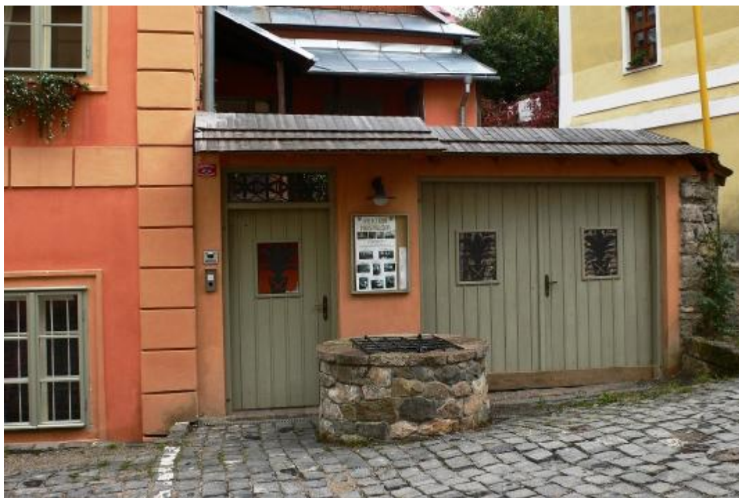
Parcelný múr so vstupnou bránou a bráničkou na dvor po obnove. Drevené prvky boli nahradené kópiami, do otvorov v bráne a nadsvetlíka nad vstupnou bránkou boli vyrobené novotvary kovaných mreží s motívom inšpirovaným zo štukovej výzdoby fasády. Bola rekonštruovaná pôvodná šindľová strieška nad vstupmi. Počas výkopových prác bola odhalená pôvodná studňa, ktorá bola konzervovaná a nadstavaná nad terén novým murivom.
