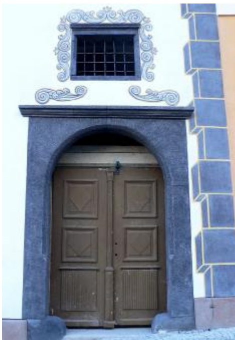
Detail rekonštruovaného renesančného portálu a okna. Proporcie maľovanej pasparty okolo nadsvetlíka a rímsy nad vstupným portálom sú nepravdepodobné, na základe poznania renesančných profilácií a proporcií. Pri rekonštrukcii renesančnej podoby fasády boli použité priemyselné materiály a technológie (vrecované omietky, umelý kameň na portál a silikátové alebo akrylové náterové materiály).
