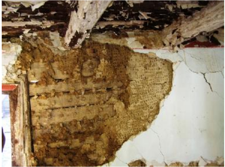
Okenné krídla dnu a von otváracie, osadené na trňové závesy a kovové uholníky, typická okenná výplň z 2. polovice 19. stor. Zrubová stena vežovej časti domu s hlinenou omietkou.
