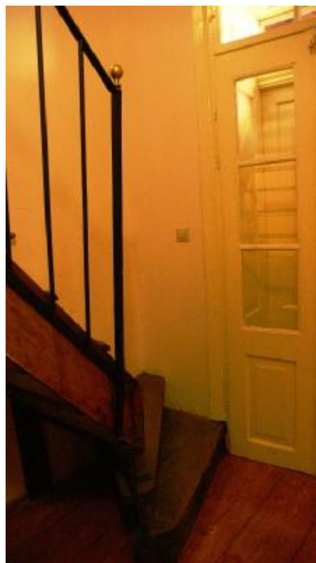
Drevené schodisko z poschodia do podkrovia s kovovým zábradlím a mosadznými detailami. Schodisko aj zábradlie bolo zachované in situ a konzervované.
