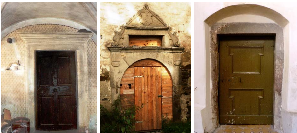
Výtvarné a umelecké hodnoty, hodnoty originálu a veku môžeme identifikovať na ich nositeľoch, ako sú portály, dverné výplne, interiérové a exteriérové omietkové vrstvy a pod.
