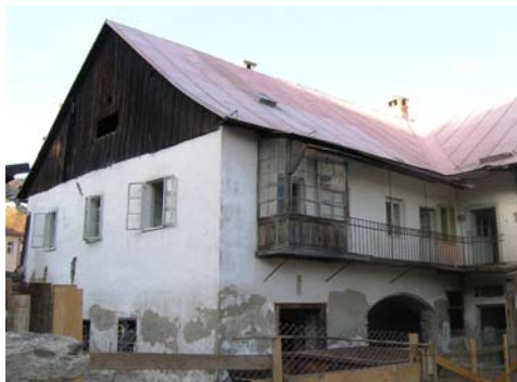
Zadná uličná fasáda – pred obnovou
