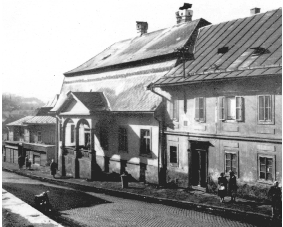
Remeselnícky dom na Dolnej 5 – v radovej zástavbe ulice (na prvej fotografii – začiatok 20. stor., na druhej fotografii – asi zo 70. rokov 20. storočia). Zdroj: Súkromný archív autorky.
