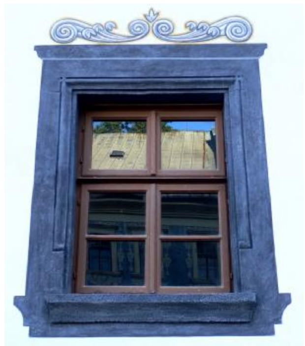
Detail rekonštruovaného renesančného portálu a okna. Proporcie maľovanej pasparty okolo nadsvetlíka a rímsy nad vstupným portálom sú nepravdepodobné, na základe poznania renesančných profilácií a proporcií. Pri rekonštrukcii renesančnej podoby fasády boli použité priemyselné materiály a technológie (vrecované omietky, umelý kameň na portál a silikátové alebo akrylové náterové materiály).
