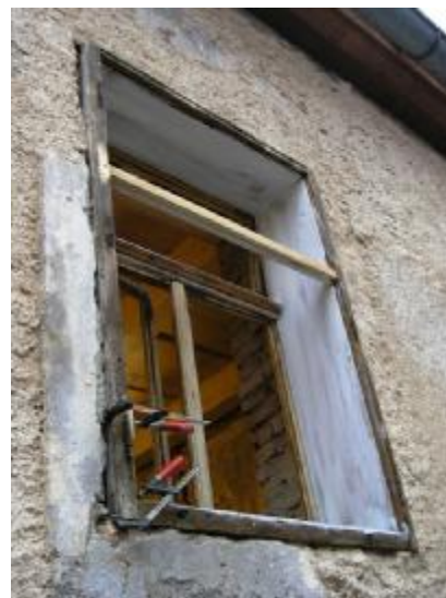
Oprava pôvodných okien na mieste (pohľad z interiéru a exteriéru).
