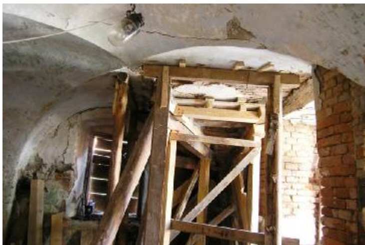
Oprava staticky narušenej klenby na prízemí – stav počas prác a po ukončení stabilizácie klenbenej konštrukcie.
