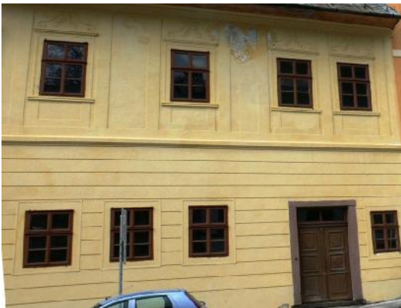
Architektonický návrh na prezentáciu klasicistickej úpravy fasády. Stav fasády po reštaurovaní poslednej klasicistickej úpravy fasády v roku 2003. Neúdržbou strechy došlo vzápätí po reštaurovaní k zatečeniu časti koruny muriva fasády.
