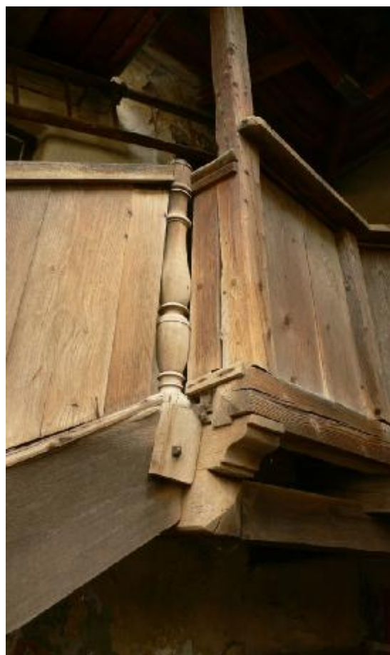
Baroková pavlač (z pol. 18. stor.) v tvare „L“ popri dvorových fasádach domu a detail tesárskych výtvarne riešených konštrukcií pavlače.
