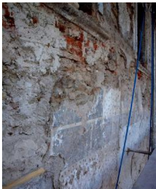
a) Otlkanie klasicistickej fasádnej úpravy, ktorá chránila zakonzervované staršie omietkové vrstvy. b) Fragменты бароквовой оштукатурки с маляванной выдубой пощас одстраћования оштукатурки перед реставрацией ренессансной подобы фасады.
