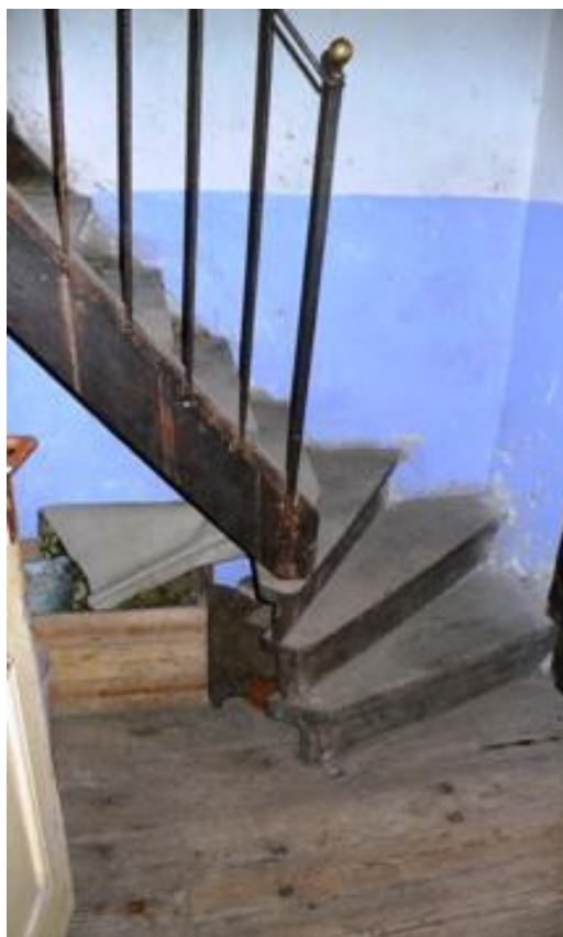
Drevené schodisko z poschodia do podkrovia s kovovým zábradlím s mosadznými detailmi.
