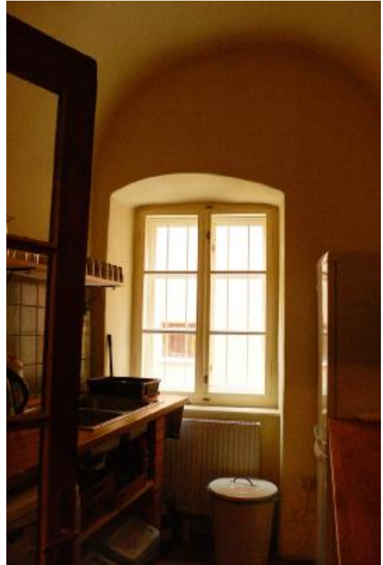
Miestnosť na prízemí s valenou klenbou, pohľad na jednej strane na pôvodné dvere z 19. storočia, na druhej strane na pôvodné okno z 19. storočia, ktoré boli konzervované a obnovená ich funkčnosť.
