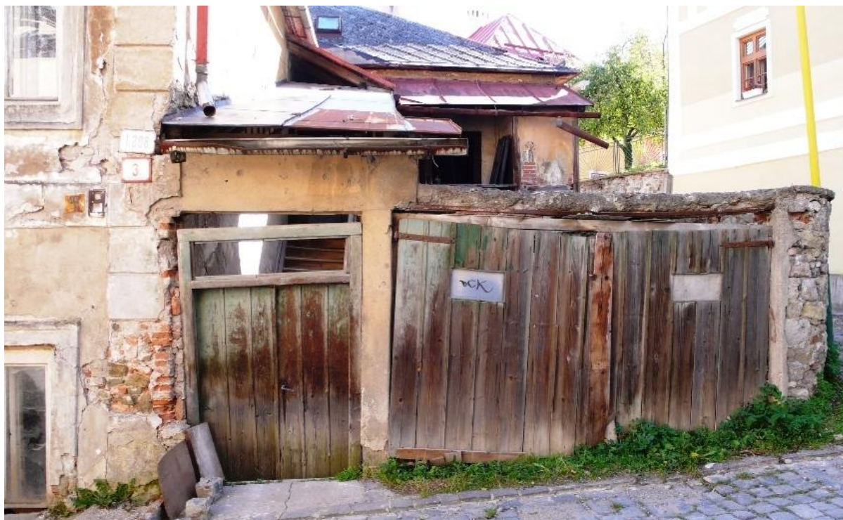
Parcelný múr okolo dvora (átria) pred domom so vstupnou bránou.
