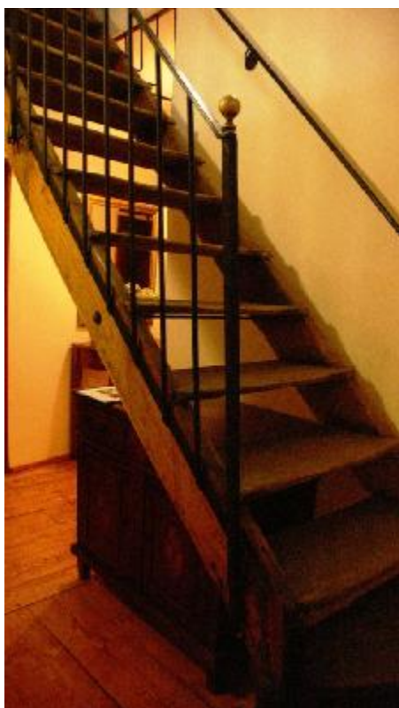
Drevené schodisko z poschodia do podkrovia s kovovým zábradlím a mosadznými detailami. Schodisko aj zábradlie bolo zachované in situ a konzervované.
