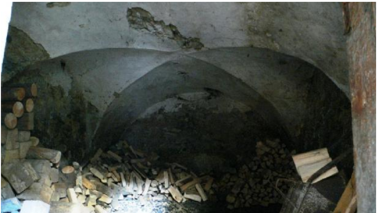
Miestnosť pod pavlačou na prízemí s valenou klenbou a styčnými lunetami (16. – 17. stor.).
