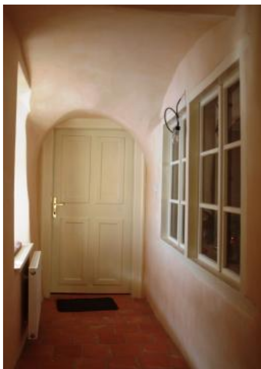
Priestory na poschodí po pamiatkovej obnove. Autenticita priestorov je dosiahnutá rešpektovaním pôvodných materiálov: drevené alebo tehlové podlahy, remeselne opravené historické dvere, stropy, vápenné omietky a vápenné nátery.
