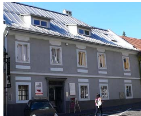
Čelná fasáda – po obnove
