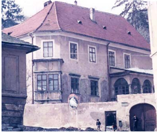
Belházyho dom na Radničnom nám. č. 1 – pred a po obnove. Pôvodné vápenné omietky s nástennými maľbami na fasáde boli nenávratne zničené počas obnovy v 80. rokoch 20. storočia a nahradené cementovou technológiou.
