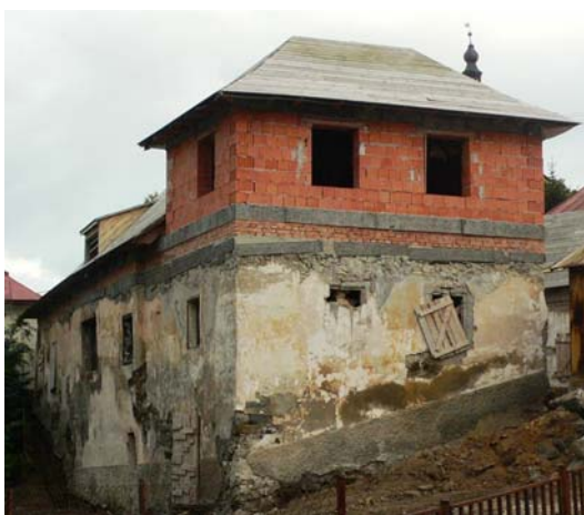
Pohľad na nárožie domu v priebehu obnovy a po obnove. Z priebehu obnovy je zrejmé, že pôvodne drevená zrubová konštrukcia bola odstránená a nahradená novou tehlovou. Zmena tvaru strechy na valbovú nad vežovou časťou degraduje jej pôvodný dominantný vzhľad v obraze mesta. Foto: Súkromný archív autorky (2. obr.), Andrea Nižňanská (4. a 5. obr.), Katarína Vošková (ostatné).
