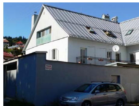
Zadná uličná fasáda – po obnove
