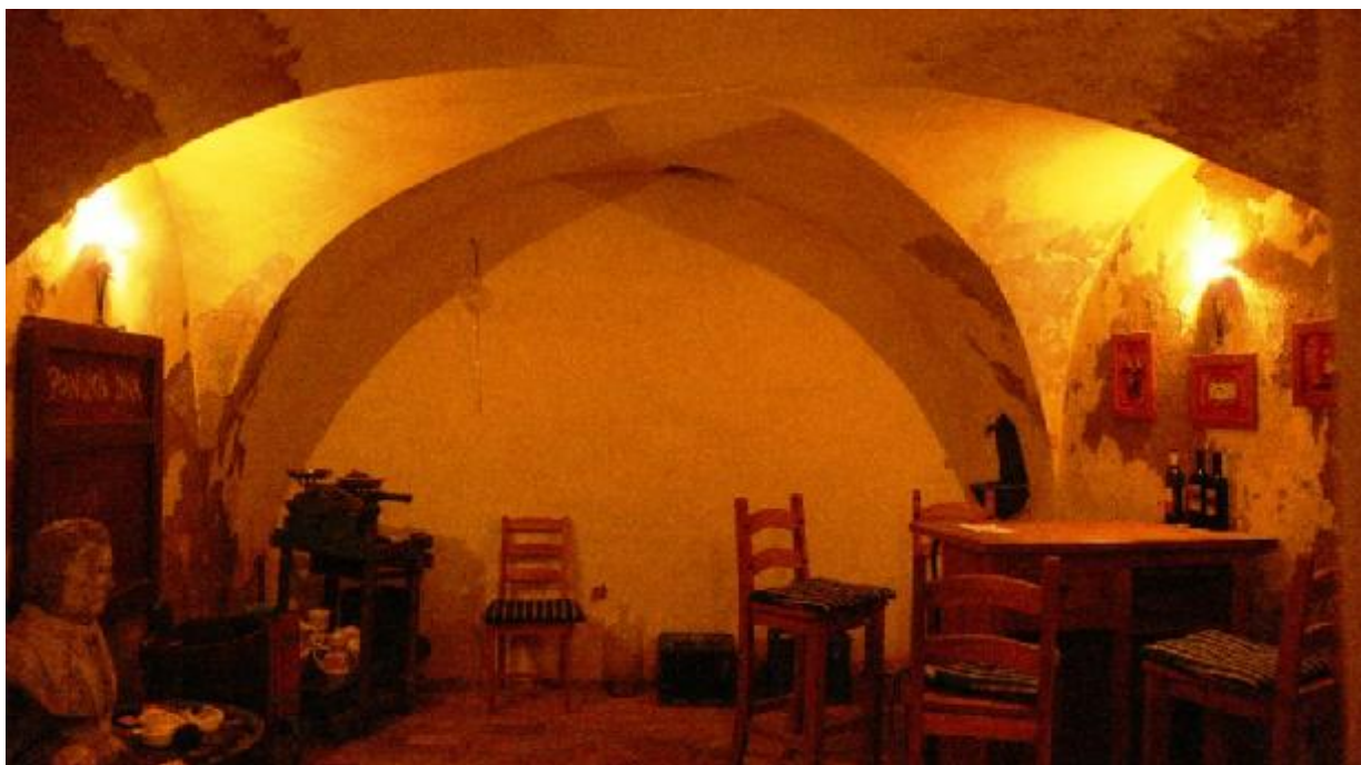
Miestnosť na prízemí s valenou klenbou a styčnými lunetami bola zachovaná, pôvodné omietky boli konzervované, chýbajúce doplnené.
