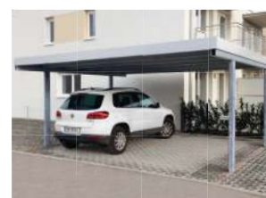
Prestrešenie parkovacích miest
