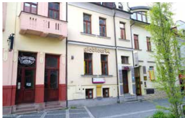
▲ 71. Súčasný stav reklamy porovnáwanej budovy.
