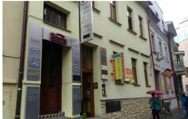
▲ 67. Starý stav fasády, kde bolo príliš veľa reklamných prvkov.
