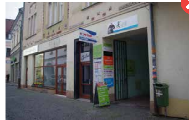
▲ 58. Chýba zjednotenie reklamy na fasáde budove.
