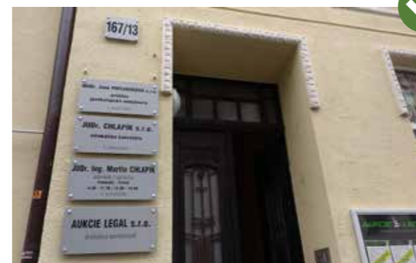
▲ 59. Koncepčné označenie jednotlivých služieb pri vstupe do budovy.
