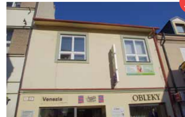
▲ 48. Necitlivé osadenie výstrče do stredu fasády nad kordónovou rímsou.
