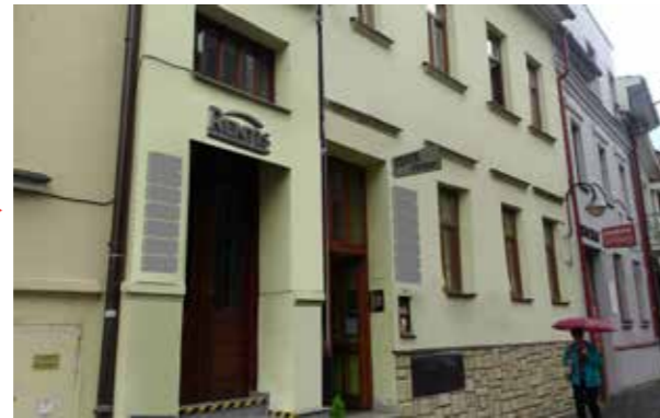
▲ 68. Príklad úspešnej realizácie zjednotenia reklamy na budove, vitrína však nie je vhodná.
