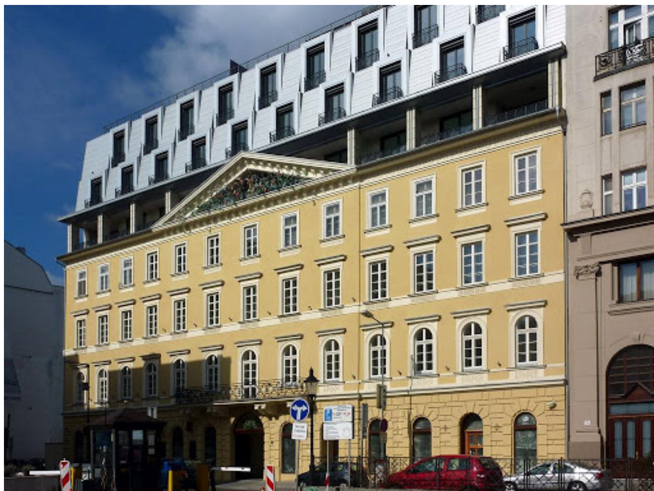
Palác Motešických po rekonštrukcii a nadstavbe
