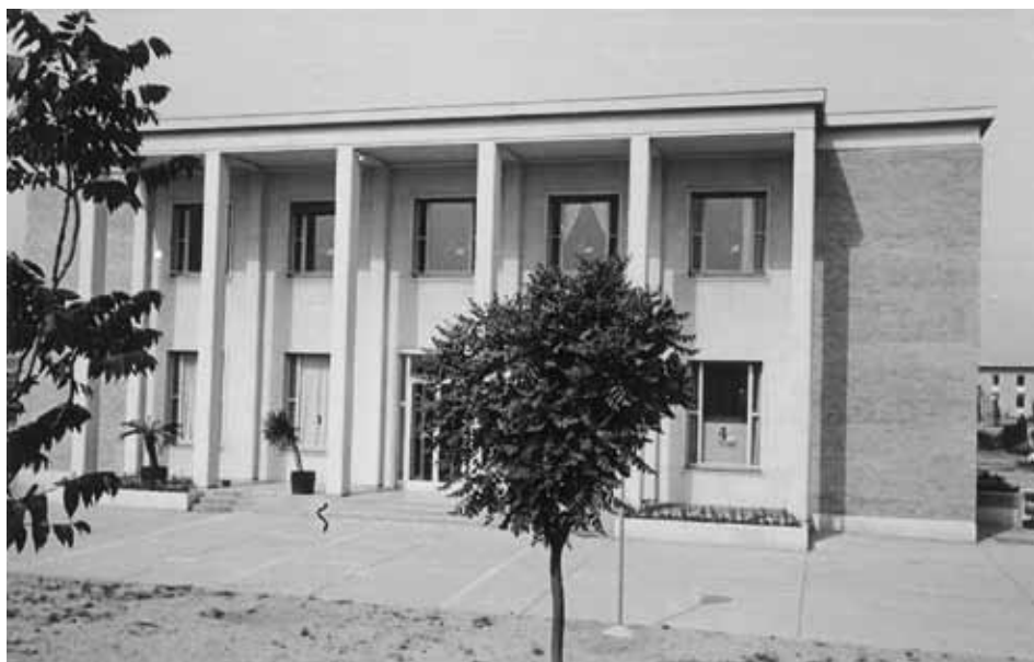
C Karel Filsak, Jiří Louda, Jan Šrámek, československé velvyslanectví v Pekingu, projekt 1956, realizace 1960 (archiv Radomíra Sedlákové).
