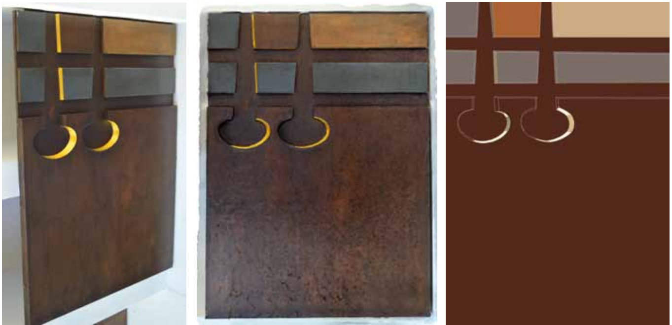
☪ Stropní kazeta představující pravděpodobně znamení cechu tkalců (vlevo), digitální síťový model vytvořený pomocí fotogrammetrie (uprostřed), digitální model vytvořený pomocí NURBS křivek v softwaru Rhinoceros (vpravo).
