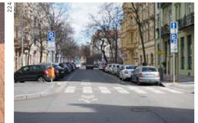
Protismerné značenie na vozovke
