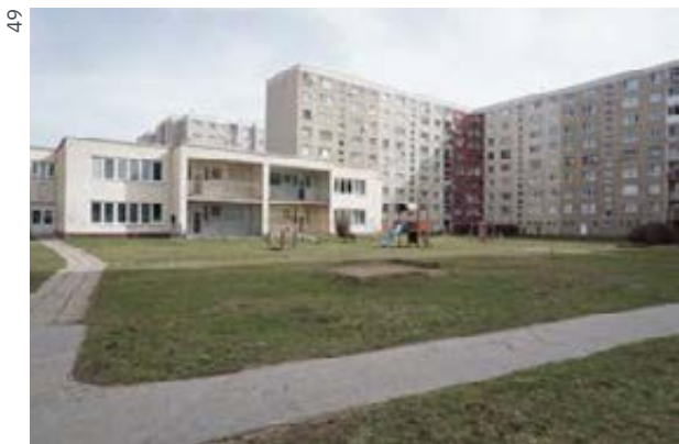
✗ Sekčov / Polyfunkčné vnútrobloky sú často zanedbané a prázdne. Ako materiál spevnených plôch dominuje asfalt a absenteje vzrastlá zeleň.
